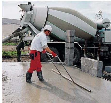
La densification naturelle garantit une homogénéité du béton dans la masse, facteur de qualité et de sécurité pour l'ouvrage.
