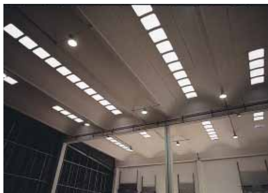
Coques de couverture.
