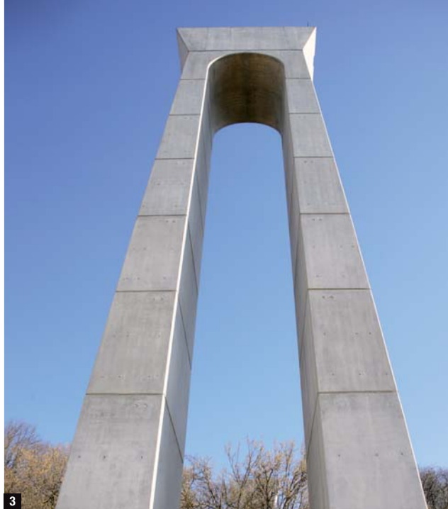
3 Pile du viaduc de la Lizaine.
