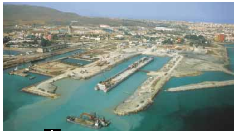
>>> 1 Le caisson de contre-jetée en sortie de souille à La Ciotat. 2 La digue flottante à Algésiras, au cours des terrassements du "bouchon" de la souille.
