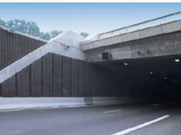
TRANCHÉE COUVERTE DE LA DÉVIATION DE LA RN 12
