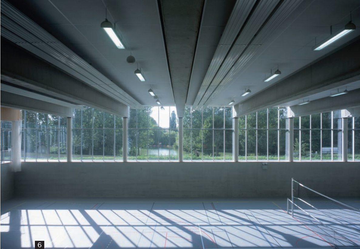
→ 6 • La grande salle de sport et ses longues poutres de 29,4 m de long. 7 • Vue de détail sur la structure de la grande salle.
