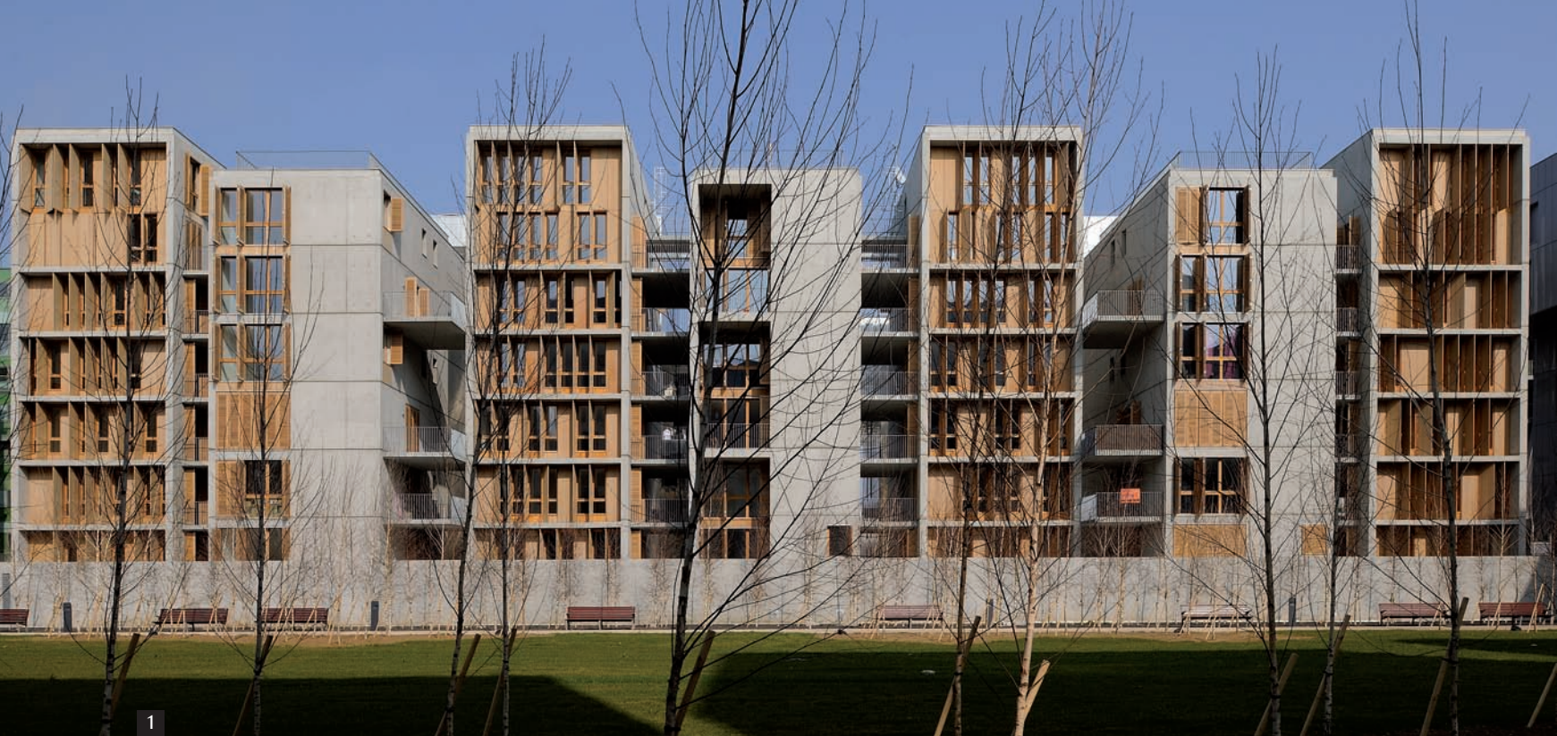
→ 1 • Le découpage de la volumétrie générale est souligné par l'enveloppe en béton brut des différents plots.
