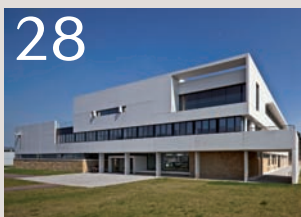
28 Bâtiment IET-INRS – Vandœuvre-lès-Nancy (54) Architectes : Atelier d'architecture Jean-Bernard Bethgnies & Stéphanie Leclair
