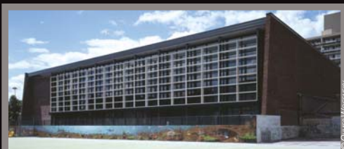
Lieu : Clichy-la-Garenne (92) / Maître d'ouvrage : Ville de Clichy-la-Garenne / Maître d'œuvre : Enia Architectes / Entreprise de gros œuvre : Buhr Ferrier Gosse
