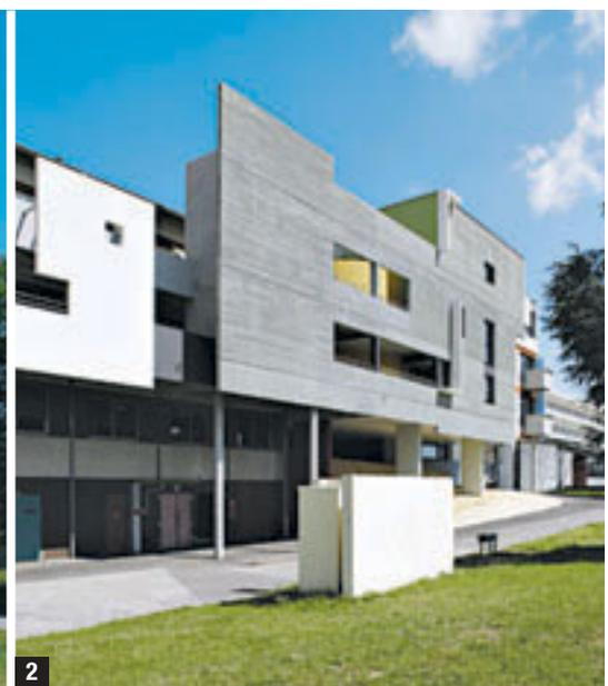
>>> **1** La façade principale d'accès est marquée par la présence d'un beau mur travaillé en béton de planchettes. **2** Ce mur, légèrement décollé du bâtiment, forme un signal et confère une identité forte à l'établissement.
