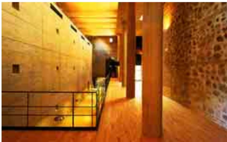
**>>> Confrontation minérale entre l'ancien et le nouveau, avec à droite le mur de pierre en maçonnerie traditionnelle du couvent, et à gauche le béton, "pierre moderne", ici utilisé pour envelopper le coffre-fort des archives.**
