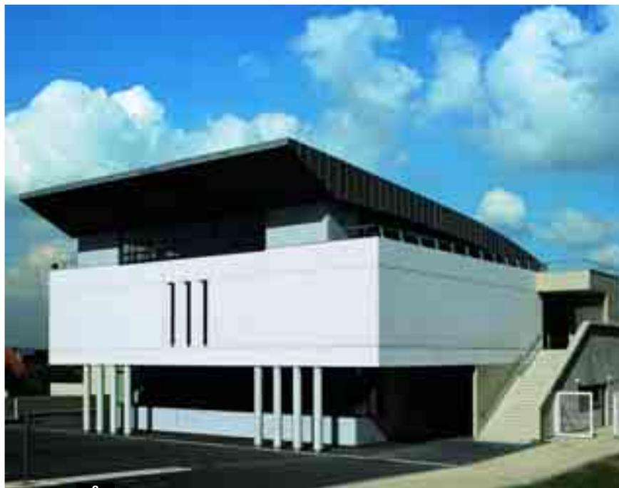
>>> **1** Les différents matériaux mettent en relief les éléments de la façade d'entrée au collège. **2** Le bâtiment abritant la cantine et la salle de gymnastique est conçu en béton autoplaçant, et mis en valeur par des ébrasements marquant l'épaisseur des voiles.
