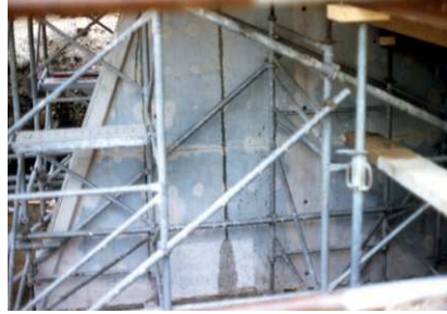
FIGURE 1 - Coloration bleu-vert observée sur des bétons contenant du laitier (à gauche, du BPE ; à droite, de la préfabrication)(© Eqiom)
