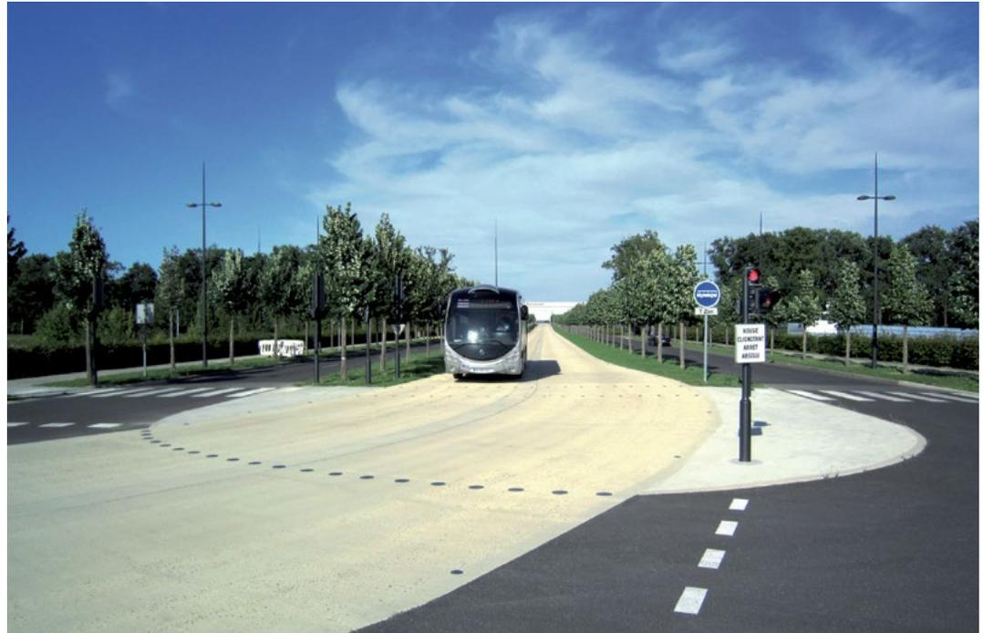
Une plate-forme de transport en site propre. Revêtement béton pour les bus et revêtement bitumineux pour le trafic véhicule © CIMbéton
