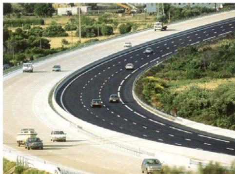
Route à fort trafic. Revêtement béton à gauche et revêtement bitumineux à droite. Séparateur béton sur le terre-plein central et glissières métal le long des bas-côtés © CIMbéton
