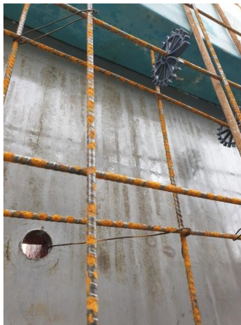
Traces de salissures et d'excès d'huile pouvant altérer le parement
