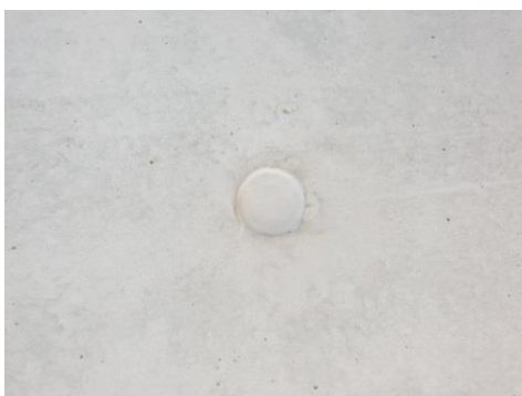
Rebouchage de trou de banche conforme
