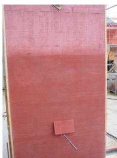
Prototype permettant de valider la teinte in-situ
