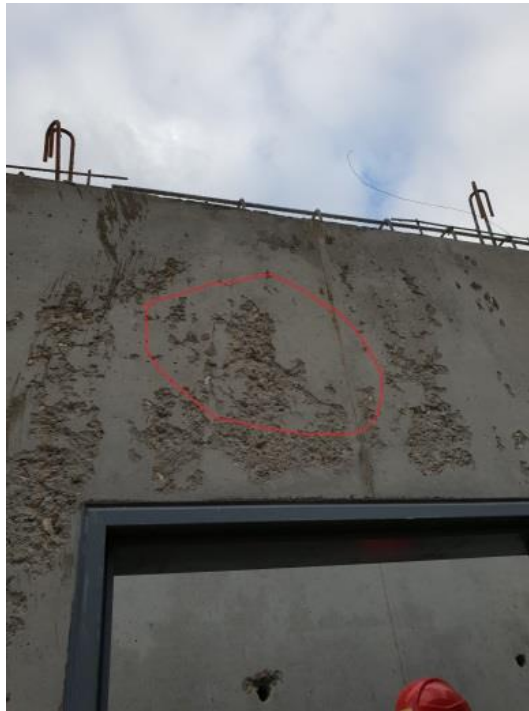
Arrachage dû à un décoffrage prématuré
