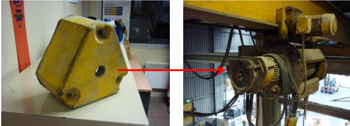
Photos Accident n°1 : Carter de protection de moteur qui se détache
