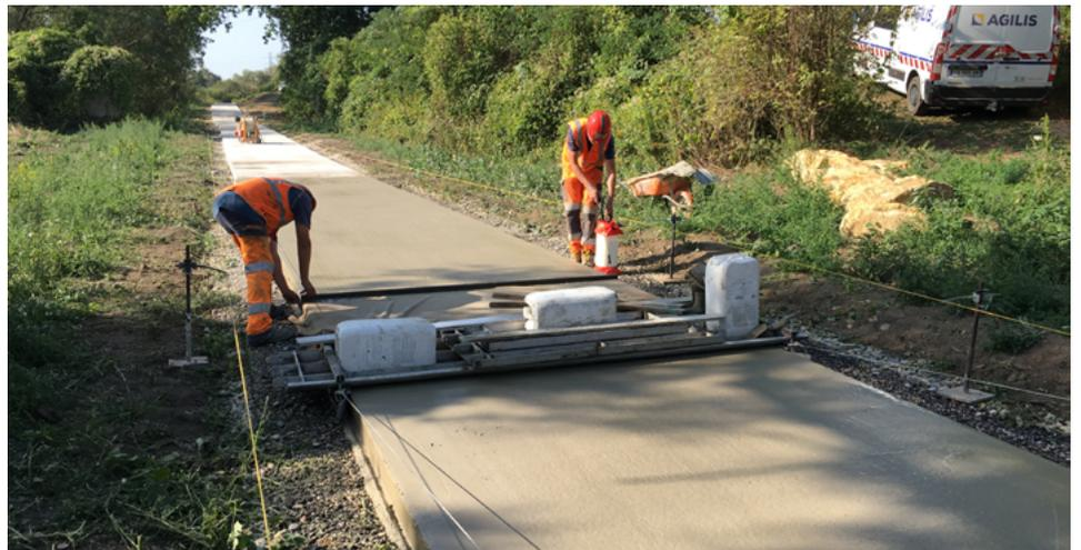
⤴ Derrière la toile de jute, la protection du béton est assurée par la pulvérisation d'un produit de cure.
