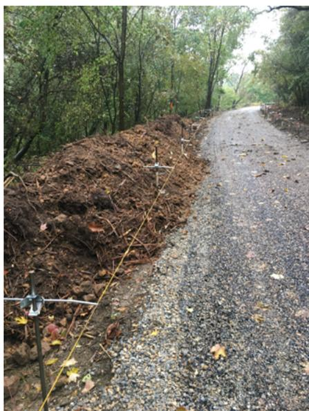
▲ Couche de forme avec enduit de protection prête à recevoir le revêtement en béton. Fils de guidage de la machine à coffrages glissants déjà en place.
