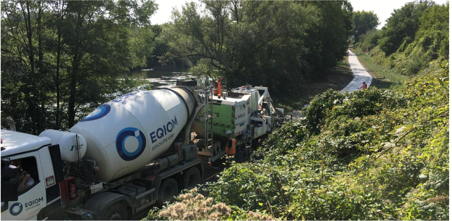
⤴ Le béton fabriqué à la centrale d'Illange d'EQIOM est livré par camions-toupies devant la machine à coffrages glissants.
