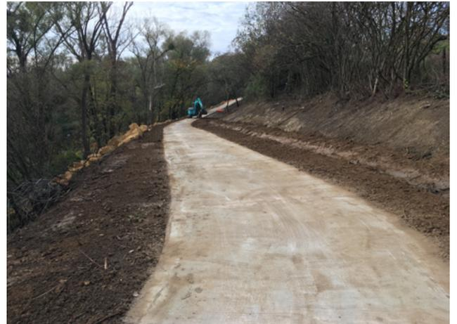
▲ Travaux de mise à niveau des accotements associés aux travaux de stabilisation des berges.
