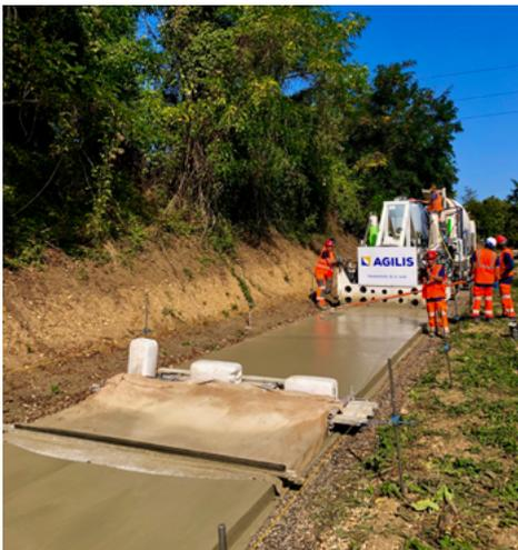
⤴ La machine à coffrages glissants, tractant la toile de jute, assure simultanément la réalisation du revêtement en béton et le traitement de surface.
