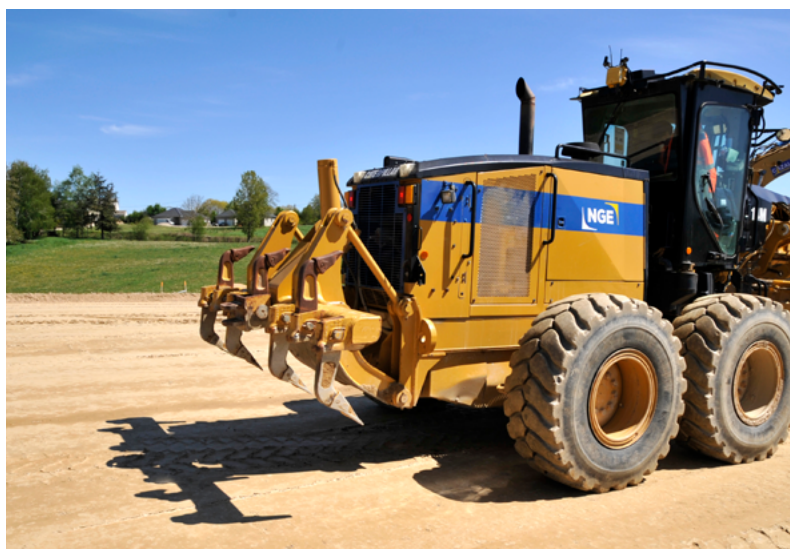
⬆ Avant épandage du LHR, le matériau est scarifié.
