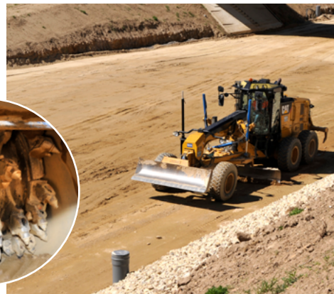
⬆ Réglage à la niveleuse pour obtenir un profil en long très régulier.
