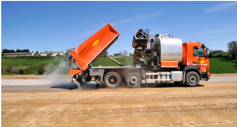
Protection de la couche de forme avec un enduit GLG.
