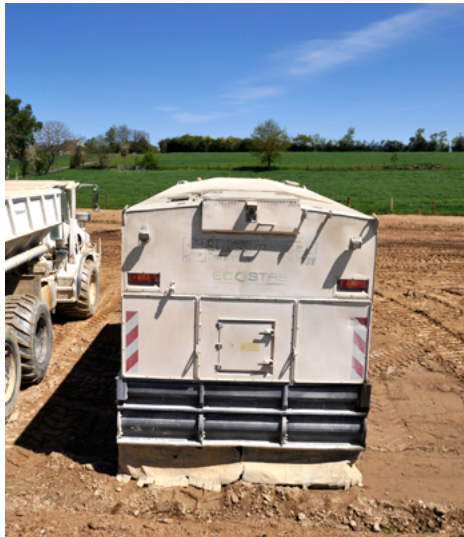
⬆ Un épandeur asservi avec contrôle pondéral a été utilisé pour l'épandage du LHR Rolac Premier à la surface du matériau.
