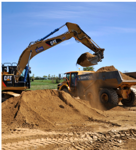
⬆ Les matériaux sont repris sur le stock à l'aide d'une pelle sur chenilles et de tombereaux articulés, puis mis en œuvre sur 40 cm par des bulls assistés par GPS.
