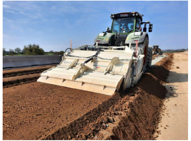
▲ Le matériau et le liant sont malaxés à l'aide d'un malaxeur tracté.
