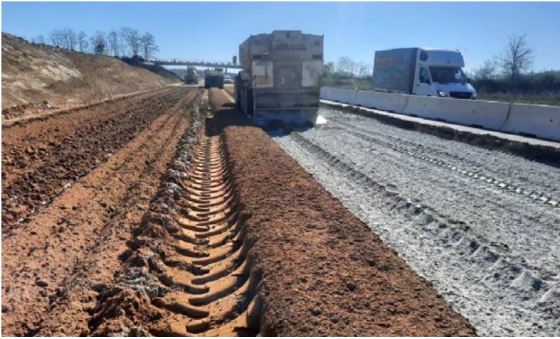
▲ Les matériaux issus des déblais ont été répandus sur le site à l'aide d'une niveleuse, sur une épaisseur homogène. Puis un épandeur asservi a procédé à l'épandage du LHR Ligex M4.
