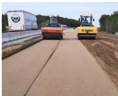
▲ Compactage à l'aide de compacteurs à bille lisse.
