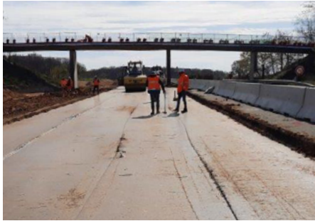
↑ Contrôle du compactage au gamma-densimètre.
