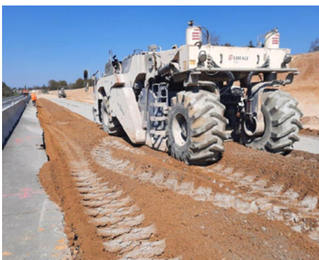
▲ Malaxage à l'aide d'un pulvimixeur.
