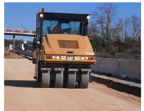
▲ Le compacteur à pneu permet de donner un bel uni.
