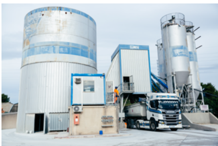
▲ Centrale Béton VICAT où le BCR a été étudié pour optimiser sa formulation et fabriqué (© Béton Vicat)
