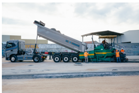
▲ Un camion-benne, bâché durant le transport du BCR, déverse le matériau dans le finisseur. Celui-ci répand, nivelle et compacte le BCR.
