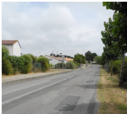
▲ L'avenue Gilbert-Burlot avant les travaux. On constate l'absence de piste cyclable sécurisée et l'état de dégradation structurelle de la chaussée.
