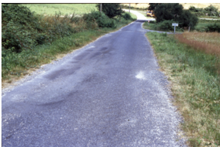
▲ Vue générale d'une route dégradée nécessitant un entretien structurel.
