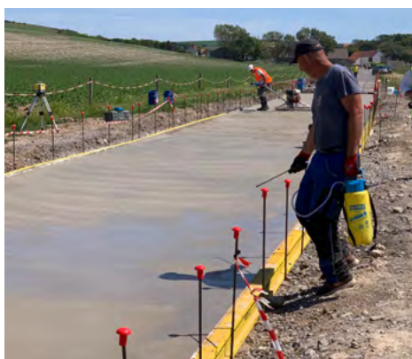
⬆ Pulvérisation d'un produit de cure à la surface du béton frais pour le protéger de la dessiccation.
