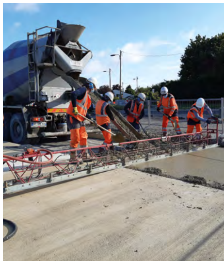
▲ Mise en œuvre du béton à la règle vibrante par demi-chaussée pour constituer la voie avec un profil en toit.
