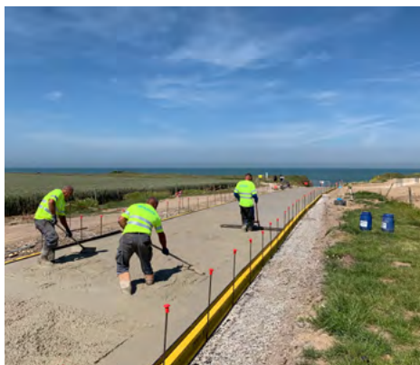
⬆ L'étalage du béton s'effectue à l'aide de différents outils : râteau, épandeur ou lissarde.
