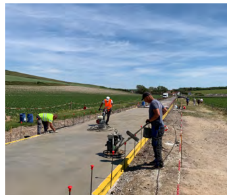
⬆ Deux lisseuses mécanisées (hélicoptères) achèvent le lissage fin.
