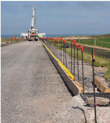
⤴ Préparation de la plate-forme support : purge, reprofilage, travaux d'assainissement, compactage et enduit superficiel.
