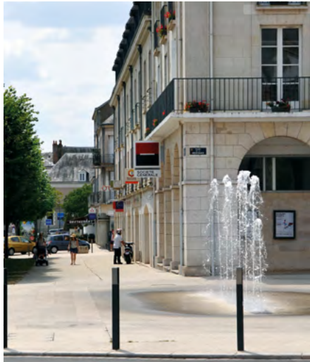
↑ Blois, quai de la Saussaye, sur la rive droite. La rénovation des trottoirs en béton bouchardé s'est accompagné de travaux d'embellissement. Ici, une fontaine.
