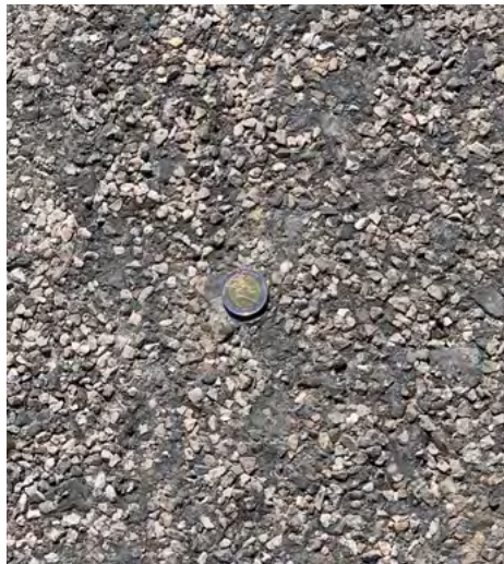
⤴ Aspect fini de la plate-forme support.
