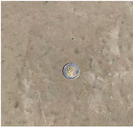
↑ Aspect du BAC après pulvérisation du produit de cure.
