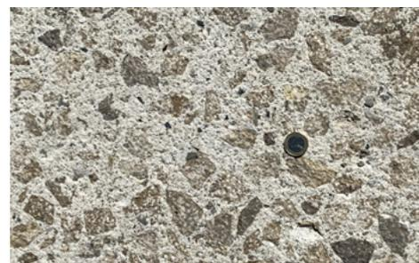
▲ Les cheminements en béton du Jardin des plantes ont été réalisés en mars et avril 2019. Signe particulier : ils sont en béton blanc intégrant de gros granulats de calcaire local 0/60 (Pontijou, près de Blois), avec une finition bouchardée
