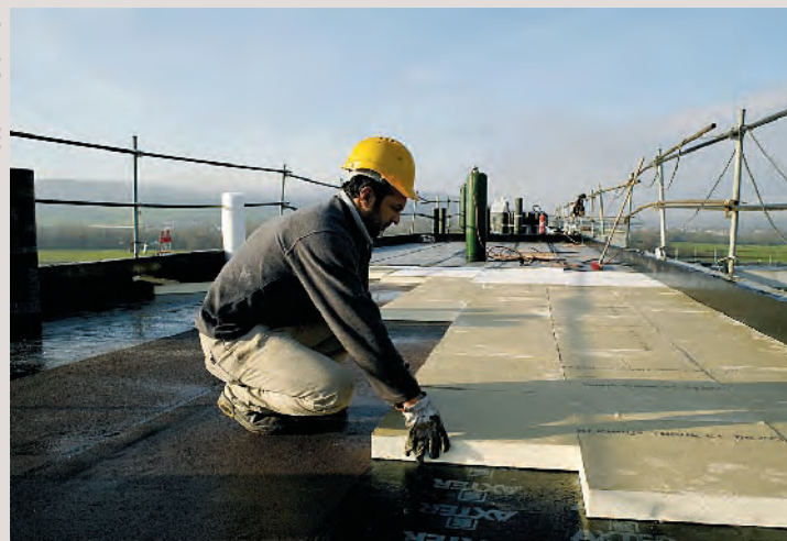
→ Pose libre de panneaux isolants sur pare-vapeur (©Knauf).
