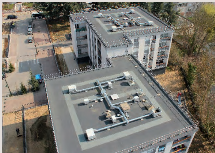
→ Équipements de désenfumage et de climatisation, résidences La Nacelle, Corbeil-Essonnes (91). HB Architecture – Archétude – Gork Piqueras.
