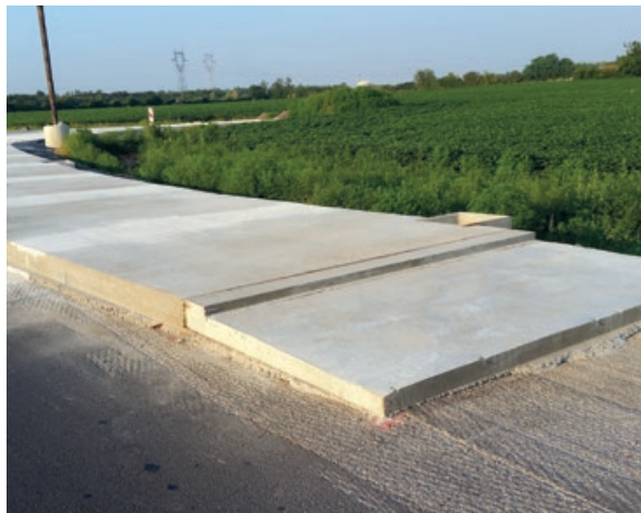
Une dalle de transition avant et après la mise en œuvre de l'enrobé.
