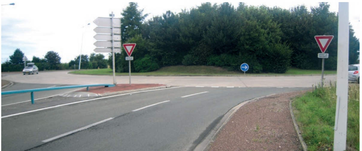
Carrefour giratoire Euro Chanel à Neuville-Lès-Dieppe (RD925). Structure BC5g sur couche de forme, réalisée en 1995.
