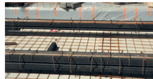
À gauche, un rail enrobé dans son complexe en caoutchouc (« jaquette »). Après coulage du béton de calage (vue des connecteurs en surface), en attente du coulage du béton de revêtement. À droite, deux rails en jaquette positionnés sur le béton de fondation, avec adjonction d'une nappe de treillis soudé, en attente du béton de calage.
