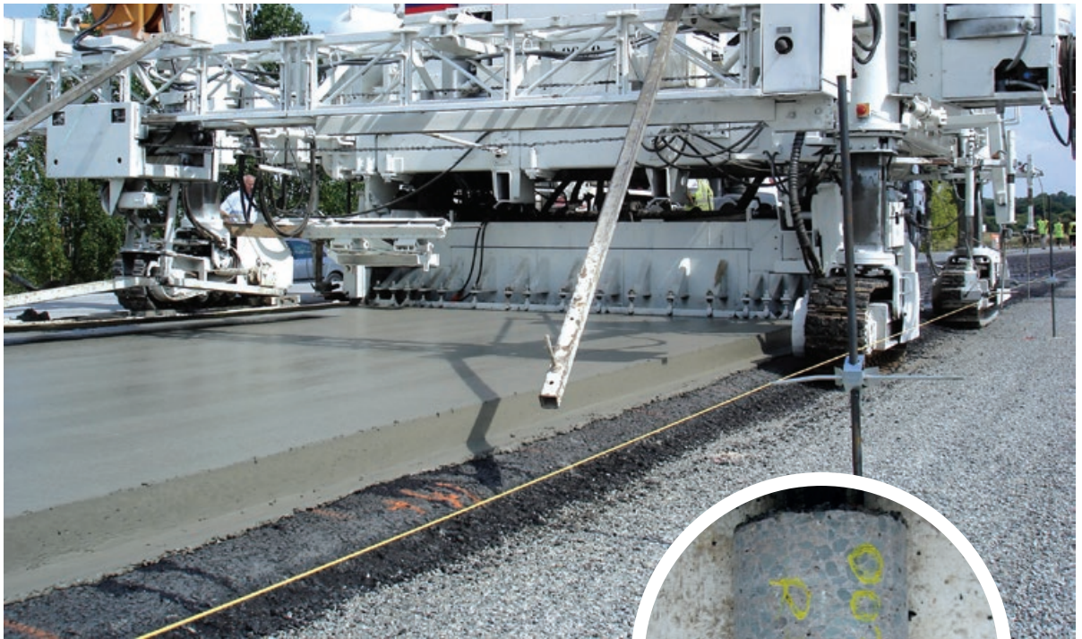
Chaussée composite. Mise en œuvre du béton, à l'aide d'une machine à coffrages glissants, sur une fondation en grave-bitume.
