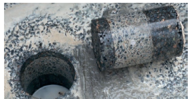
Carotte prélevée dans une chaussée composite illustrant parfaitement le collage BAC sur GB3.
