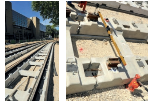
Plate-forme en « ladder track », destinée à accueillir une couverture végétale sur la séquence 1, le long des remparts historiques.
