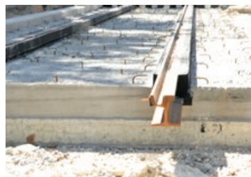
À gauche, un rail enrobé dans son complexe en caoutchouc (« jaquette »). Après coulage du béton de calage (vue des connecteurs en surface), en attente du coulage du béton de revêtement. À droite, deux rails en jaquette positionnés sur le béton de fondation, avec adjonction d'une nappe de treillis soudé, en attente du béton de calage.
