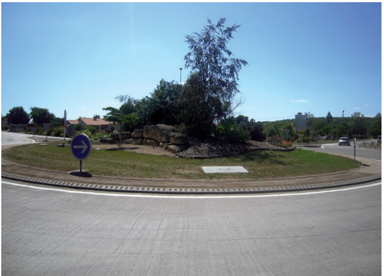
Carrefour giratoire d'Airvault, réalisé en 2001, avec une structure composite en béton armé continu sur grave-bitume (BAC/GB3).
