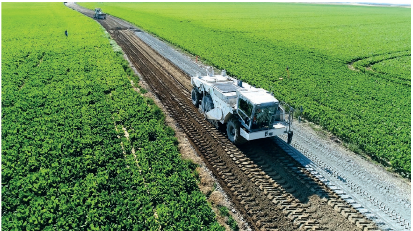
La RD36a en cours de retraitement à froid au liant hydraulique routier, fin juin.
