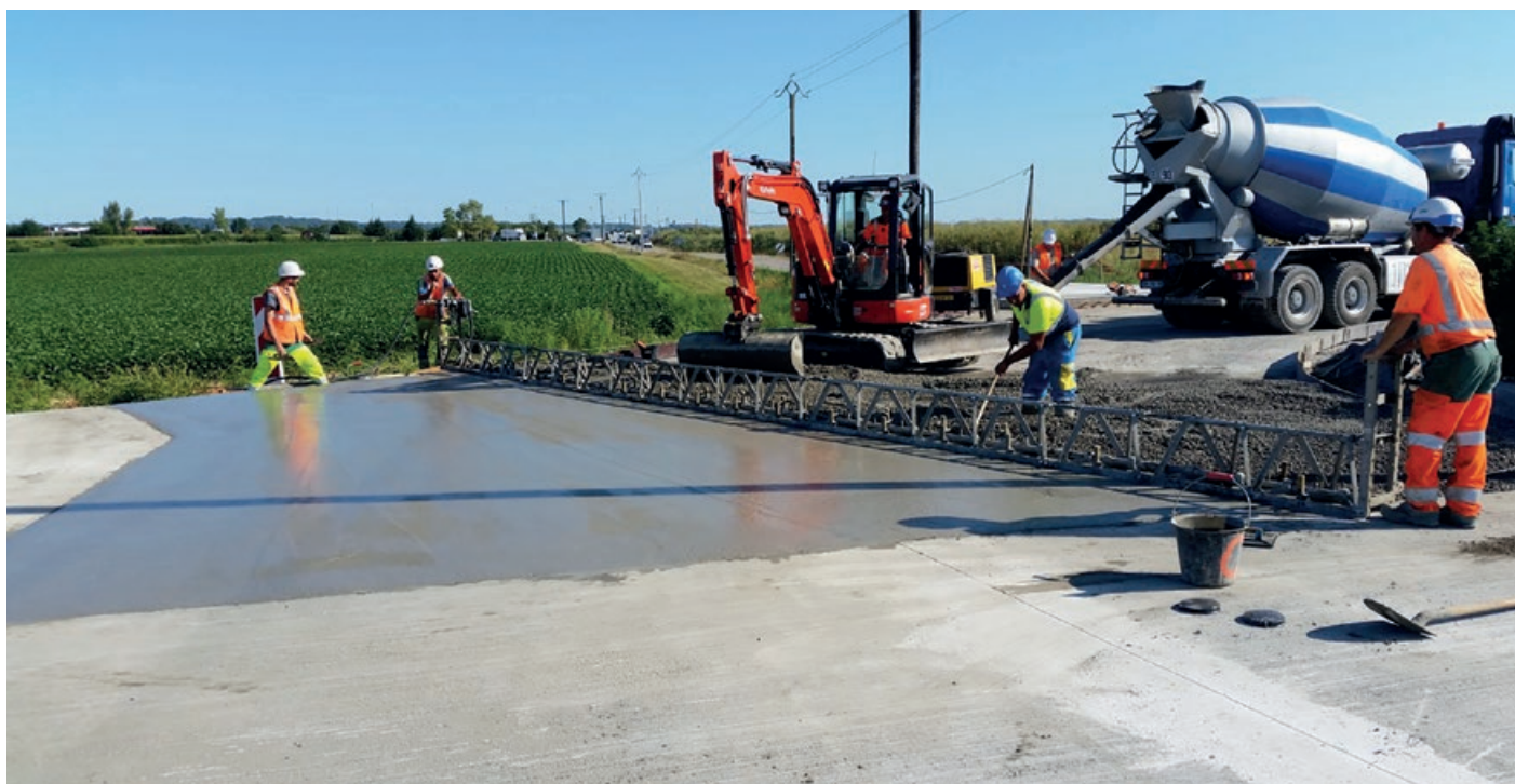
Le giratoire de Pérouges, sur la RD65b, lors du bétonnage. La société Agilis a utilisé une règle vibrante pour assurer la mise en place du béton.
