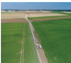
PHOTO DE COUVERTURE // Vue aérienne du chantier de retraitement à froid au liant hydraulique routier de la RD36a, au sud de la Seine-et-Marne, réalisé fin juin par la société Routes et chantiers modernes (RCM), avec du Rolac Optimum de Saint-Pierre-la-Cour de LafargeHolcim.
