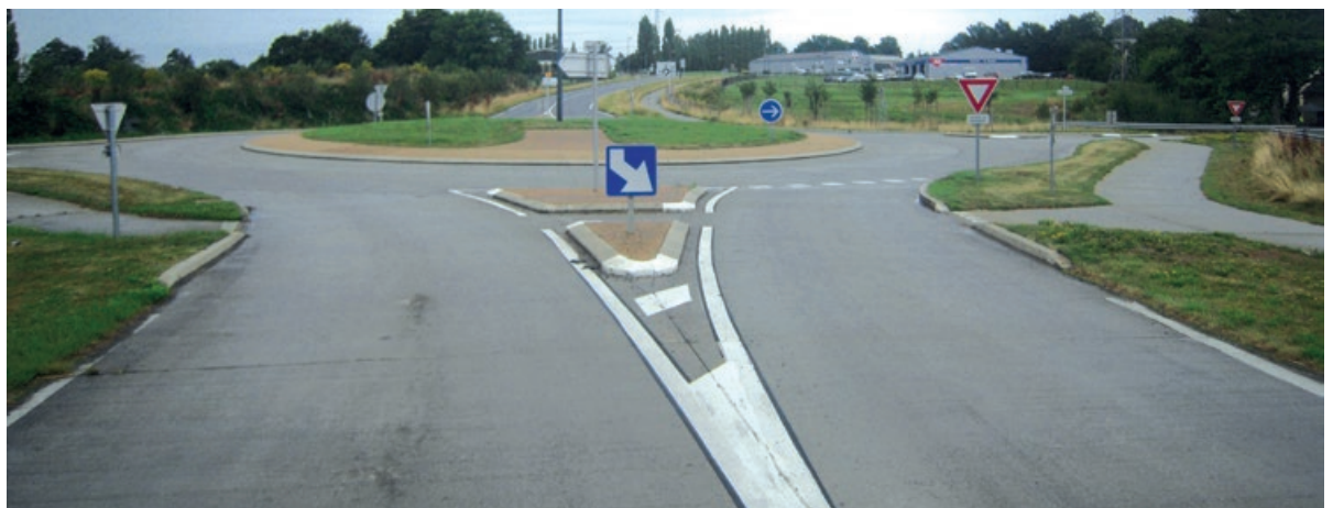
Carrefour giratoire de Saint-Pierre-la-Cour. Structure BC5g sur GB3, réalisée en 2005.
