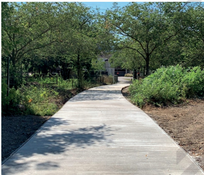
L'allée d'accès à la ferme pédagogique, réalisée en béton 100 % recyclé.
