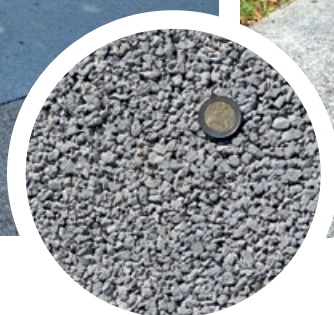
Allées en béton drainant permettant l'infiltration des eaux.
