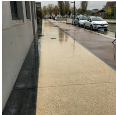
Les trottoirs en béton bouchardé intégrant une piste cyclable (en enrobé).
