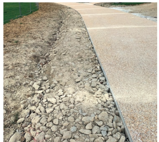
Accotements avec poutres longitudinales (0,60 ml x 0,80 ml) utilisant des granulats issus du béton concassé, de granulométrie 60/80.
