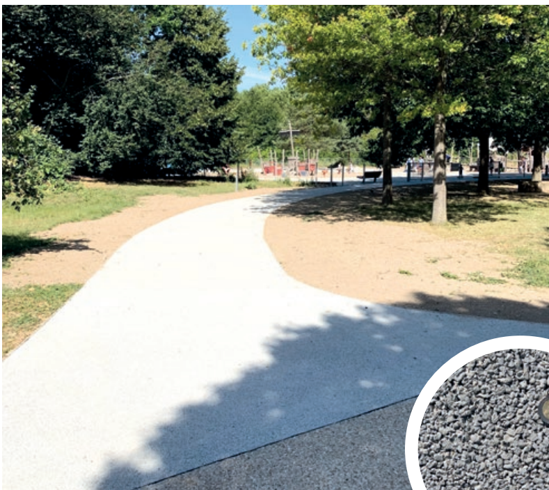
Allées en béton drainant permettant l'infiltration des eaux.
