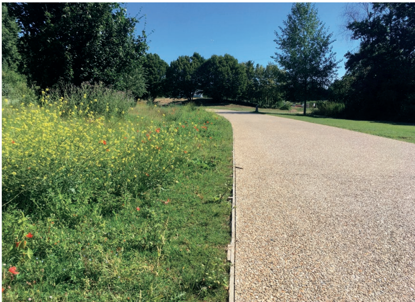
Les nouveaux cheminements piétonniers en béton désactivé.
