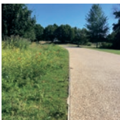
PHOTO DE COUVERTURE // Parc des Chanteraines (92) : les nouveaux cheminements piétonniers en béton désactivé.
