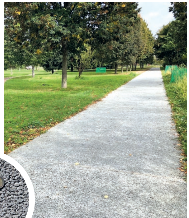
En médaillon : aspect de surface du béton drainant.
