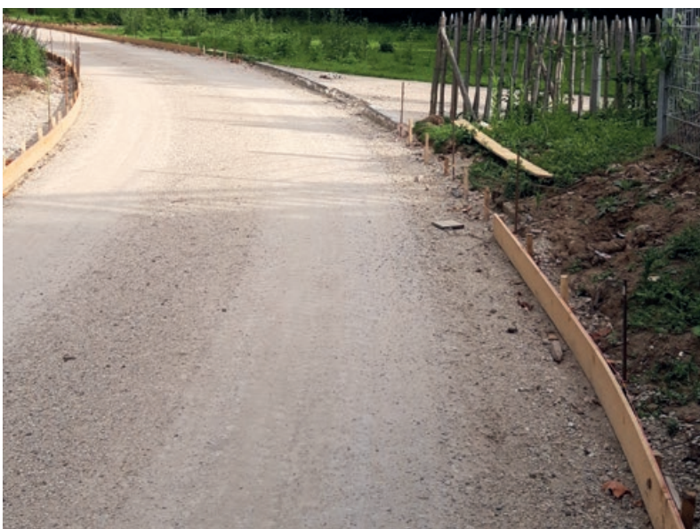
Le coffrage des nouvelles allées, avec la sous-couche en béton concassé.
