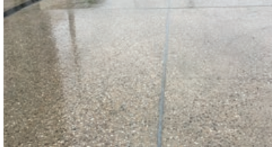
Une voirie en béton bouchardé (avec joint métallique Terrajoint de chez Peikko).
