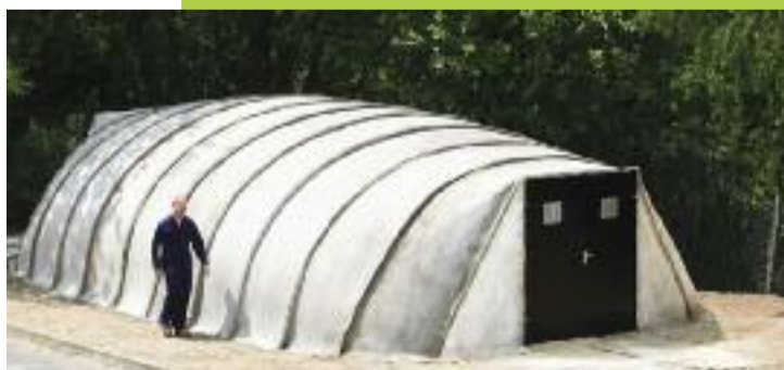
L'abri en béton (concrete canvas shelter)
