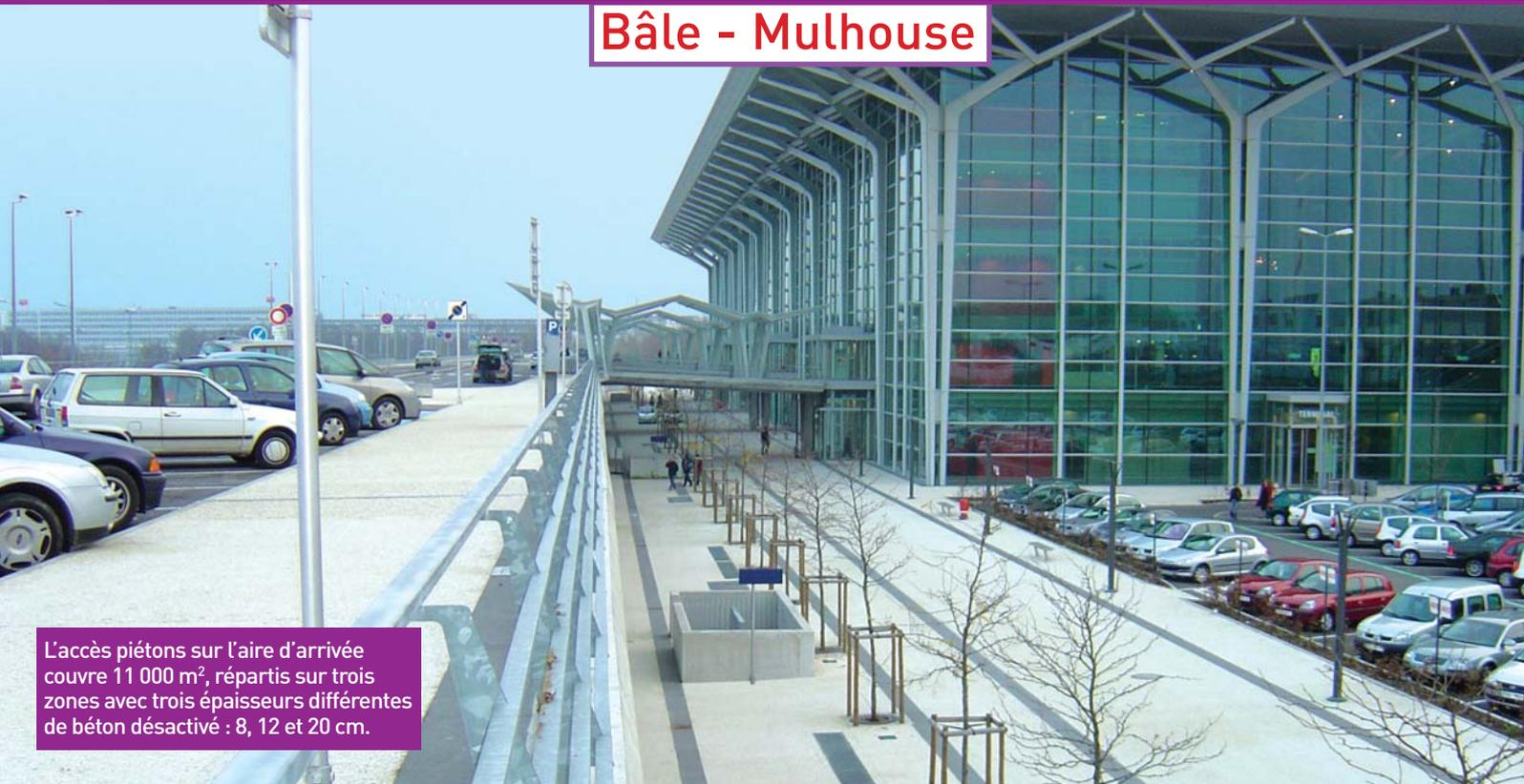
L'accès piétons sur l'aire d'arrivée couvre 11 000 m<sup>2</sup>, répartis sur trois zones avec trois épaisseurs différentes de béton désactivé : 8, 12 et 20 cm.
