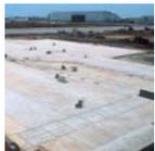
Des bétons à 6 MPa en flexion pour supporter l'Airbus A 380
