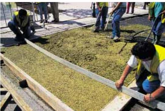
▲ Le béton est ensuite vibré à l'aiguille et nivelé à la règle métallique.
