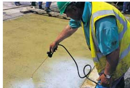
▲ Un agent désactivant est pulvérisé à la surface du béton frais pour permettre un dénudage ultérieur des granulats au jet d'eau à haute pression.
