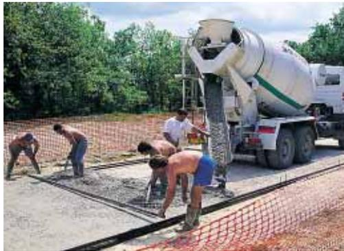
▲ Nivellement du béton à la règle.
