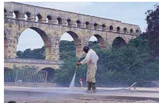
▲ Hydrogommage au jet d'eau haute pression additionné de sable.
