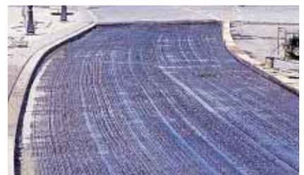
▲ La couche de grave bitume est rabotée et soigneusement nettoyée pour offrir au béton les conditions d'une parfaite adhérence.
