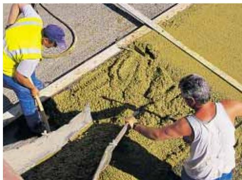
▲ Un ouvrier oriente la rampe pour répartir le plus uniformément possible le béton.
