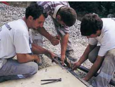
▲ Mise à la forme des coffrages en tube d'acier avant le coulage du béton.
