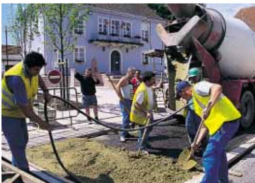
▲ Trente minutes de trajet sont nécessaires à l'acheminement du béton sur le chantier par camion-toupie.
