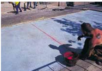
▲ Le tracé des traits de scie correspondant aux joints de retrait est réalisé à l'aide d'un cordon élastique trempé dans de la peinture.
