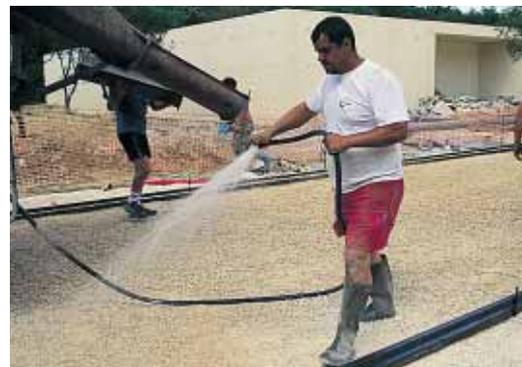
▲ Humidification de la couche support en tout-venant compacté avant le coulage du béton.
