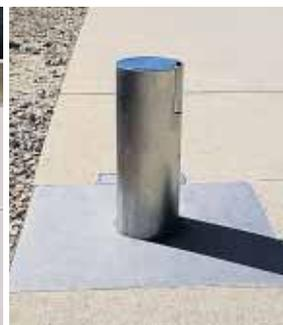
▲ Seul un tube inox émerge au-dessus des poubelles encastrees sous la chaussée béton.
