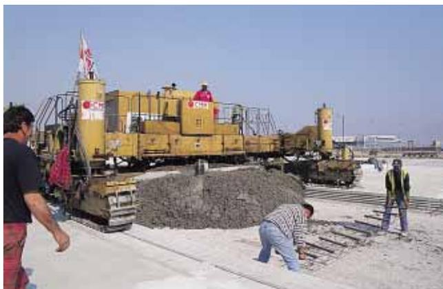
▲ Des goujons montés sur des paniers métalliques sont positionnés à l'aplomb du futur joint de dalle. Ce dispositif transfère les charges d'une dalle à l'autre sans entraver les mouvements de dilatation.
