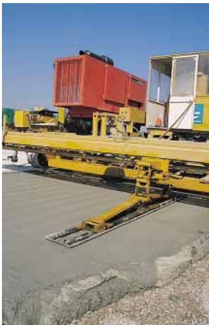
▲ Après avoir été mis en œuvre, préréglé, coffré et vibré par la *slip form*, le béton est lissé par une taloche de grande dimension.
