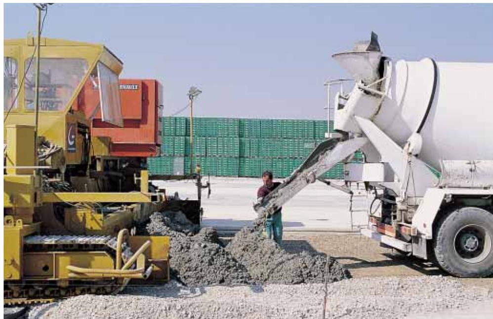
▲ Provenant de la centrale de BPE Hexabéton d'Aigues-Vives, le béton est déversé à l'avant de la machine à coffrage glissant.
