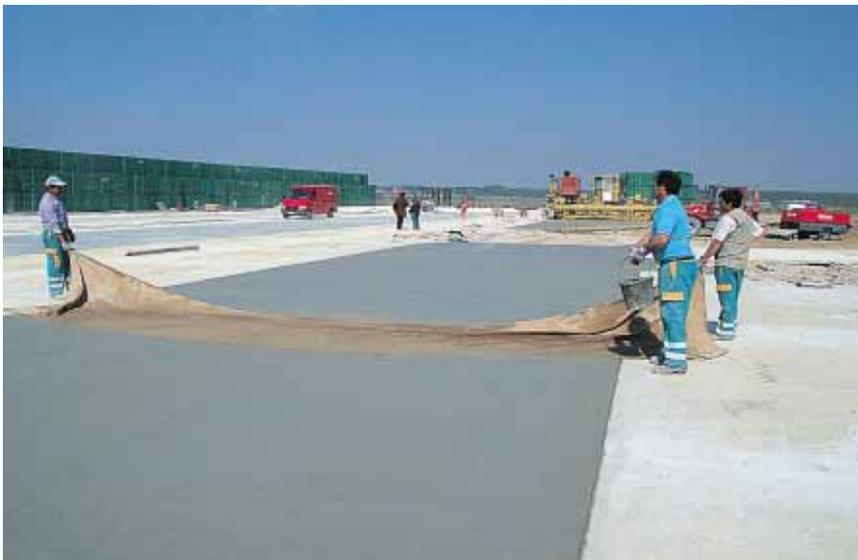
▲ Avant la pulvérisation d'un produit de cure, le passage d'une toile de jute unifiée et structure la surface de la chaussée en béton.
