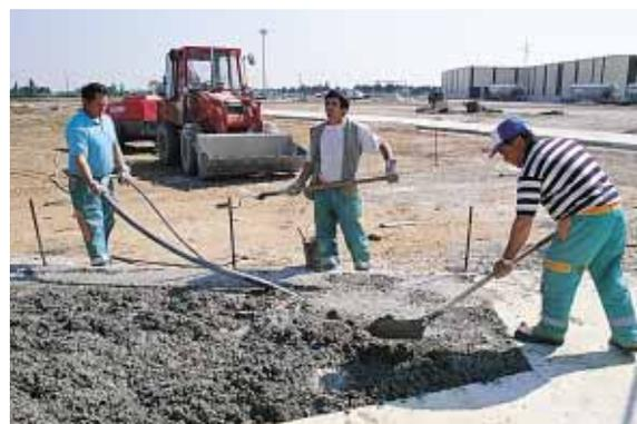
▲ La réalisation des zones complexes s’effectue manuellement, en continuité avec les zones “mécaniques” pour éviter tout risque de décohésion ou de fissuration de la dalle de béton.
