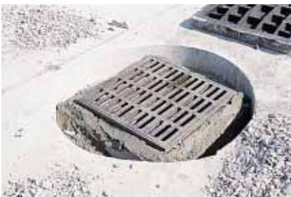
▲ Des réservations et des caches protègent les avaloirs d'eaux pluviales lors du passage de la machine à coffrages glissants.
