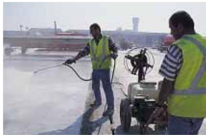
▲ Un produit de cure protège le béton de la dessiccation pendant les premières heures nécessaires à la montée en résistance.
