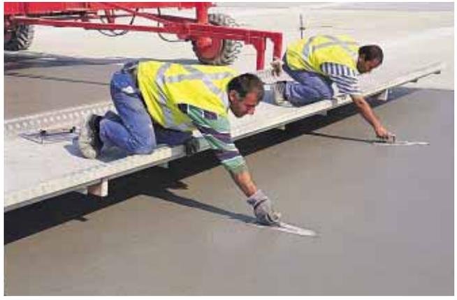
▲ Une taloche automatique montée à l'arrière de la machine effectue dans un mouvement de va-et-vient un premier lissage de la surface du béton. L'opération est complétée par un lissage manuel à la taloche. Une toile de jute trainée à l'arrière de la passerelle complète la finition.
