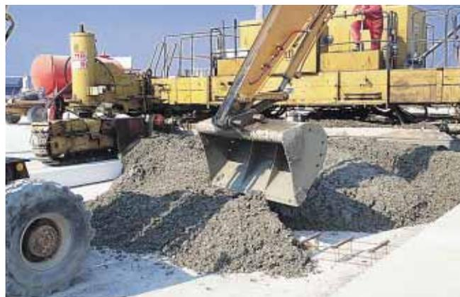
▲ Une pelle hydraulique déverse du béton sur les goujons afin de les immobiliser avant le passage de la machine à coffrages glissants.
