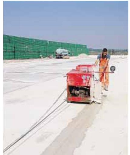
▲ L'élargissement du joint à la scie précède son garnissage par un produit d'étanchéité anti-kérosène.
