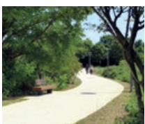
PHOTO DE COUVERTURE // D'une longueur d'environ 1,2 km, la nouvelle portion de la Tégéval est le fruit de la mise en œuvre d'un béton stabilisé produit par EQIOM : Articimo® Stabilisé Terre de Sahara.
