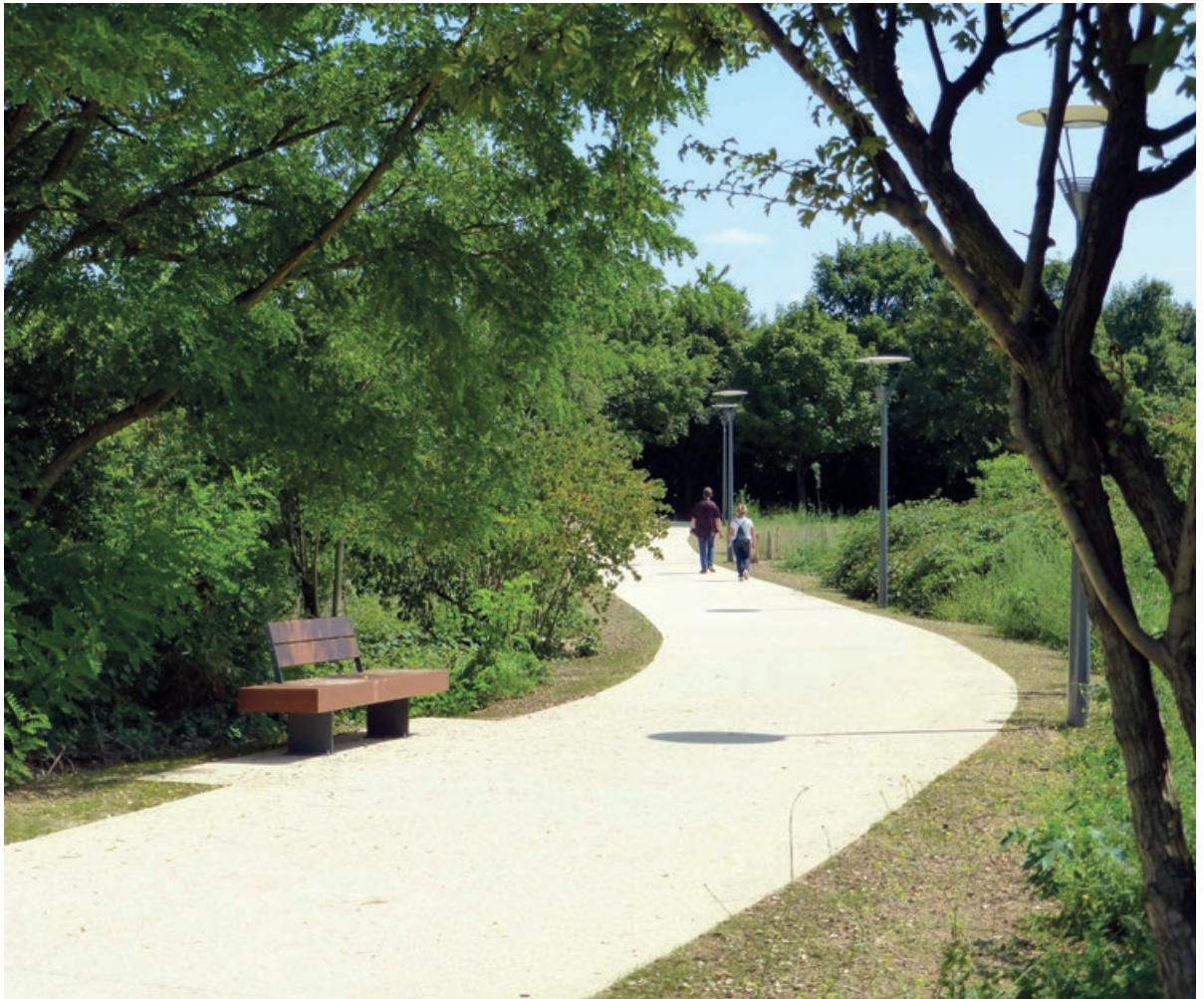
D'une longueur d'environ 1,2 km, la nouvelle portion de la Tégéval est le fruit de la mise en œuvre d'un béton stabilisé produit par EQIOM : Articimo® Stabilisé Terre de Sahara.
