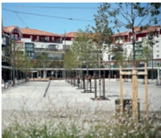
PHOTO DE COUVERTURE // La place du marché de La Teste-de-Buch, commune voisine d'Arcachon. Suite à un appel d'offres lancé en septembre 2016, la société Sols-Aquitaine y a mis en œuvre plus de 14 000 m 2 de béton avec plusieurs finitions : microbouchardage, lissage et désactivation notamment.
