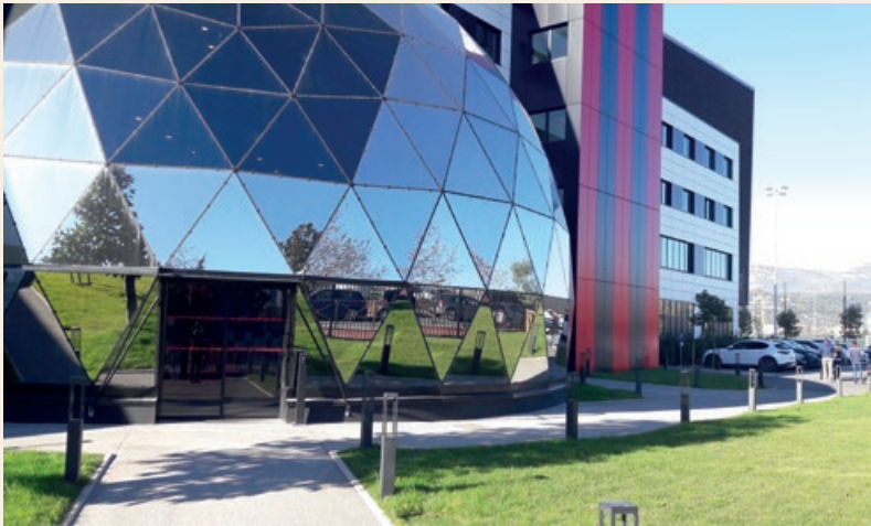
Le nouveau centre d'entraînement et de formation de l'OGC Nice est mis en valeur par 470 m 2 de cheminements réalisés en béton désactivé.
