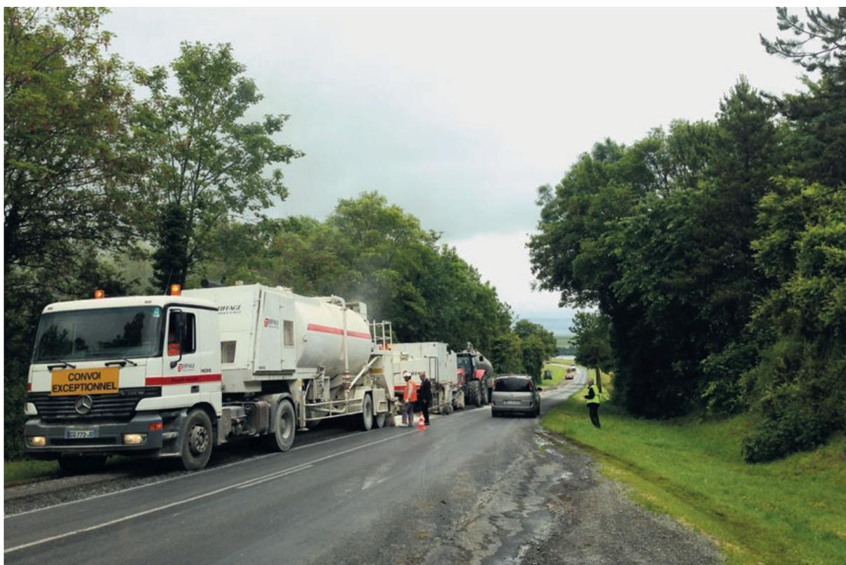
Chaque rive de la RD1 a été retraitée de façon distincte, en fonction des dégradations constatées. Cela a permis de réaliser le chantier sous circulation.
