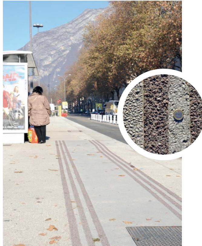
Des bandes rugueuses de couleur grenat, créées sur le béton désactivé, signalent la présence de voies cyclables.
