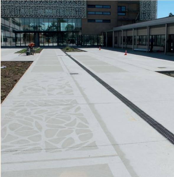
Sur les espaces extérieurs du collège, les motifs « façon moucharabieh » ont été réalisés en sablant le béton, recouvert d'un pochoir ou de matrices métalliques.
