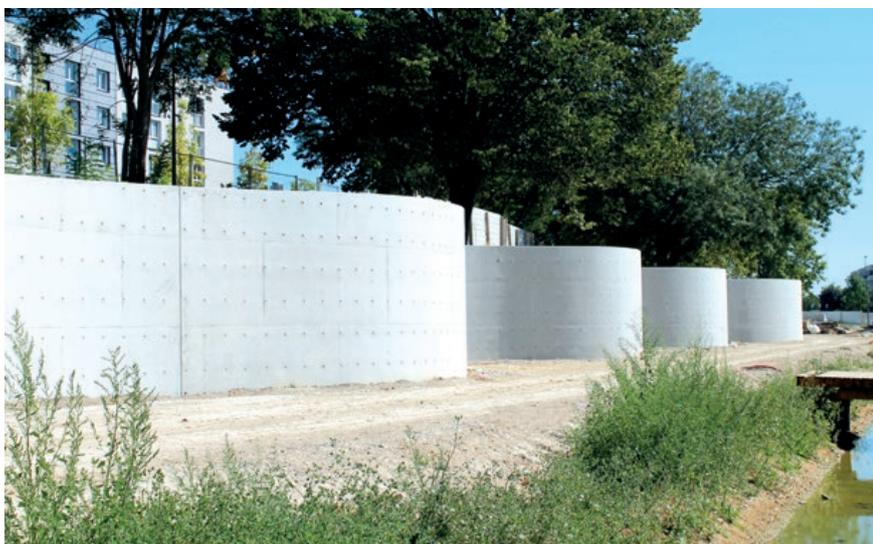
Le « mur courbe » en béton armé réalisé en 2015 par Mineral Service dans le parc Molière des Mureaux. Long de près d'un kilomètre, l'ouvrage tout en ondulations est large de deux mètres, avec une hauteur variant de 39 cm à... 3,30 m !
