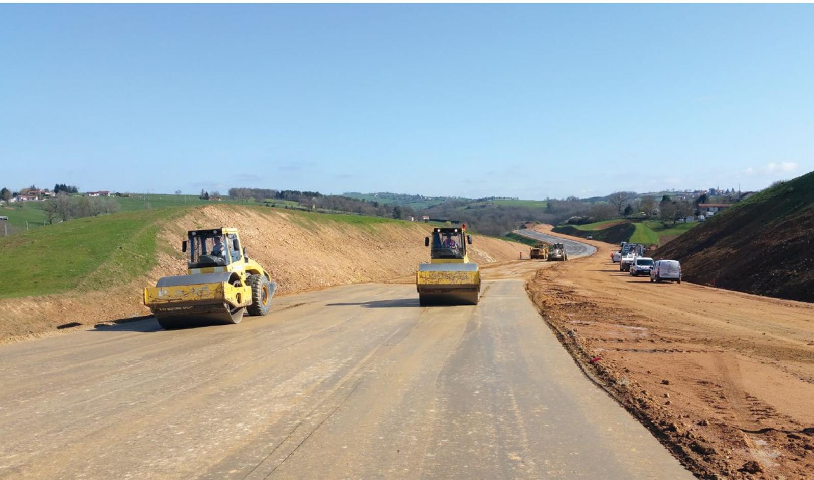
Le tronçon 2 x 2 voies sur 4,5 km implique la création d'une plate-forme de 25 m, qui nécessite environ 700 000 m<sup>3</sup> de terrassement. Au total, l'opération une fois achevée se soldera par le traitement de 115 000 m<sup>2</sup> de couche de forme au liant hydraulique routier.
