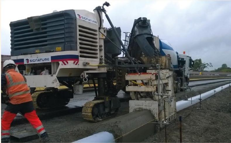
La réalisation de la poutre du réseau d'appel d'urgence (RAU) de l'A63 sur laquelle sera coulée la GBA (glissière en béton adhérent).
