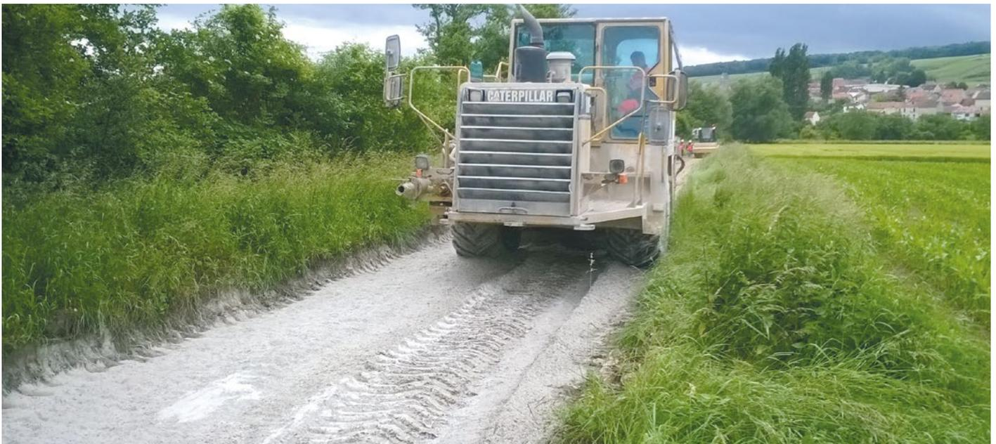
Après préparation du sol (ouverture au scarificateur ou au ripper) et vérification de l'état hydrique, le liant hydraulique routier ROC AS d'Eqiom est épandu. La qualité et la régularité de l'épandage font l'objet d'un soin rigoureux !
