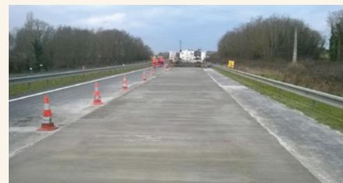
Deux phases de l'intervention sur l'A71 : mise en place des barres en acier haute adhérence HA 16 le mardi et bétonnage à la machine à coffrages glissants le mercredi.
