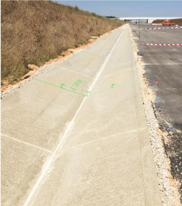
Sur le chantier du doublement de l'A9, l'un des plus grands chantiers de France, Signature réalise une partie des assainissements de surface – dont plus de 16 000 ml de caniveaux – et des ouvrages de sécurité en béton extrudé.
