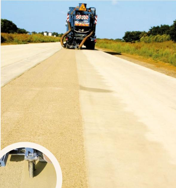
Pour le traitement de la couche de roulement, c'est la technique de l'hydroprojection qui a été retenue.
