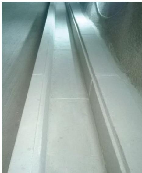
Les caniveaux en U pour chemin de câbles dans le métro de Santiago : un exemple du savoir-faire français dans le domaine du béton extrudé.
