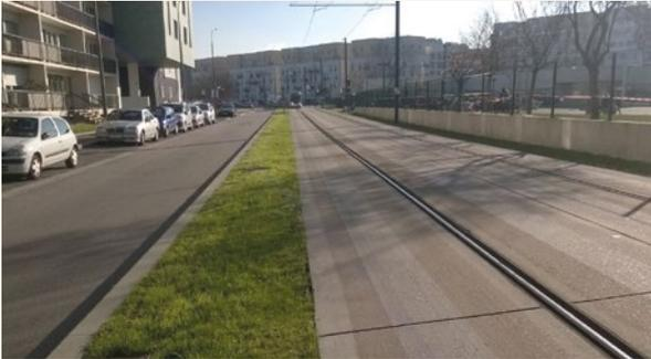
La plate-forme du tramway T6 est constituée d'une dalle courbe en béton non armé et goujonné.
