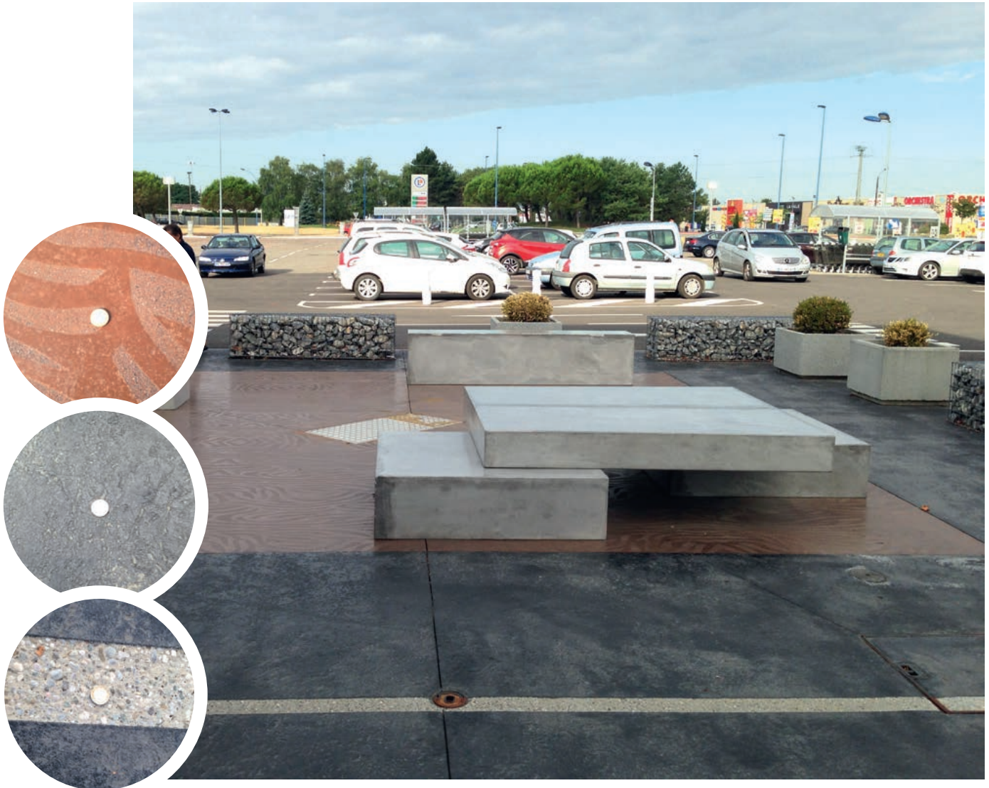
Le béton noir imprimé en motifs légers est traversé par une bande de guidage au sol pour sécuriser le déplacement des personnes aveugles ou malvoyantes (PAM). À l'arrière du banc en béton, une bande d'éveil à la vigilance (BEV).
