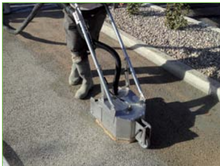
La Tour d'Aigues : grâce à un nouveau procédé, il est désormais possible de gommer une très fine couche de laitance et de faire apparaître les granulats sans obstruer les vides du béton drainant.
