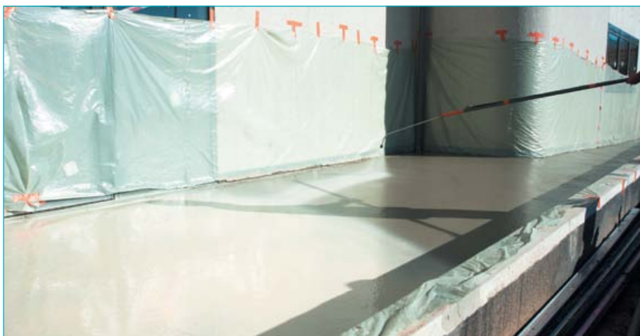
Phase de désactivation : le produit retardateur de prise est appliqué à l'aide d'un pulvérisateur à canne allongée, pour augmenter son rayon d'action.
