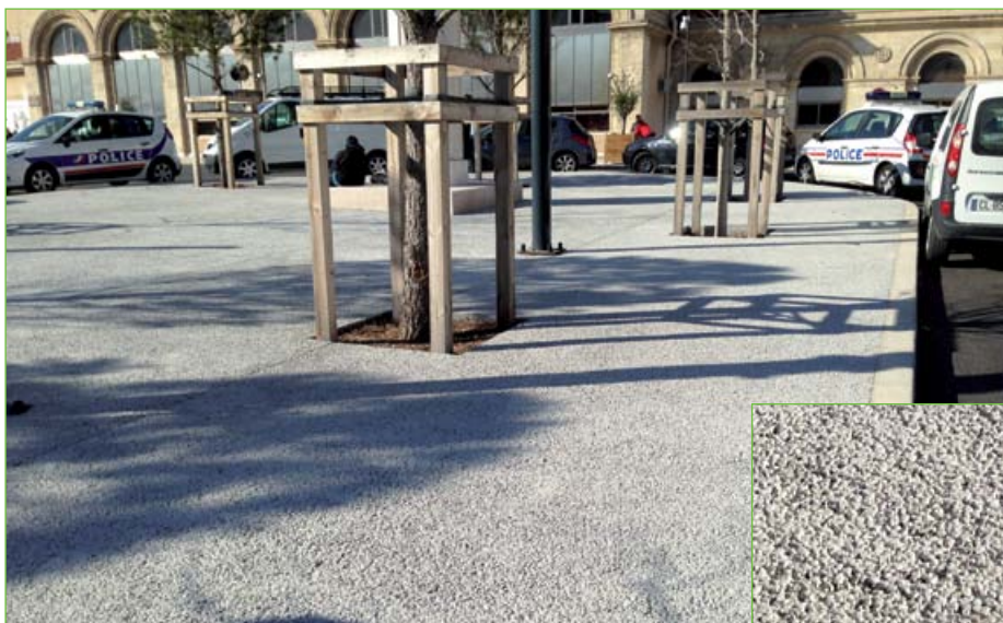
Marseille : l'"îlot de béton poreux" d'une surface de 350 m 2 réalisé au cœur du square Narvik (épaisseur de 20 cm, granulométrie 6/10).
