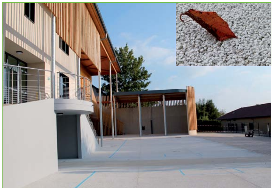
Ambronay : la cour de récréation de la nouvelle école maternelle d'Ambronay a été réalisée avec un béton drainant spécialement formulé. Son granulats (4/6) de couleur grise provient de la carrière de Péroutes. Sa porosité après compactage est de l'ordre de 19 %.
