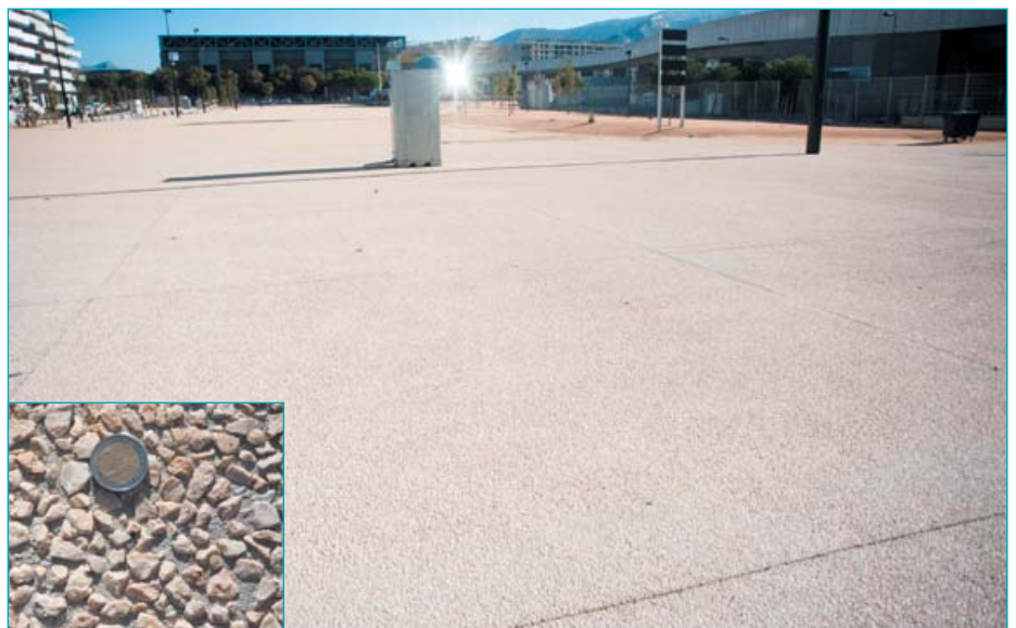
Le granulats choisi - un concassé jaune très clair provenant de la carrière de Beausset dans le Var - donne un aspect chaleureux et naturel à l'esplanade. Une touche méditerranéenne...
