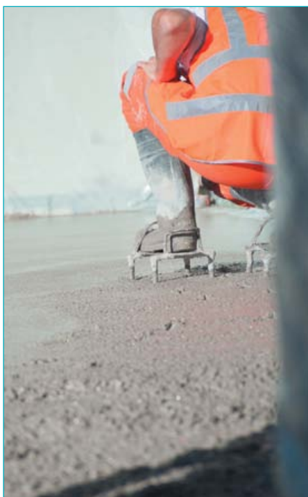
Juché sur des semelles surélevées, un des équipiers taloche à la main l'ensemble de la surface, avant la phase de désactivation.
