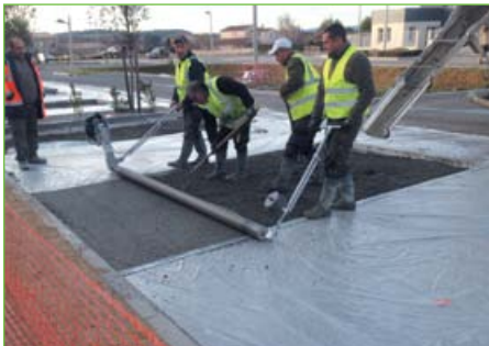
La Tour d'Aigues : le béton (ciment CEM III/ 42,5 A Calcia Beaucaire, additif Grace Pieri, granulats 2/6) a été égalisé avec un rouleau mécanique non vibrant (Striker).
