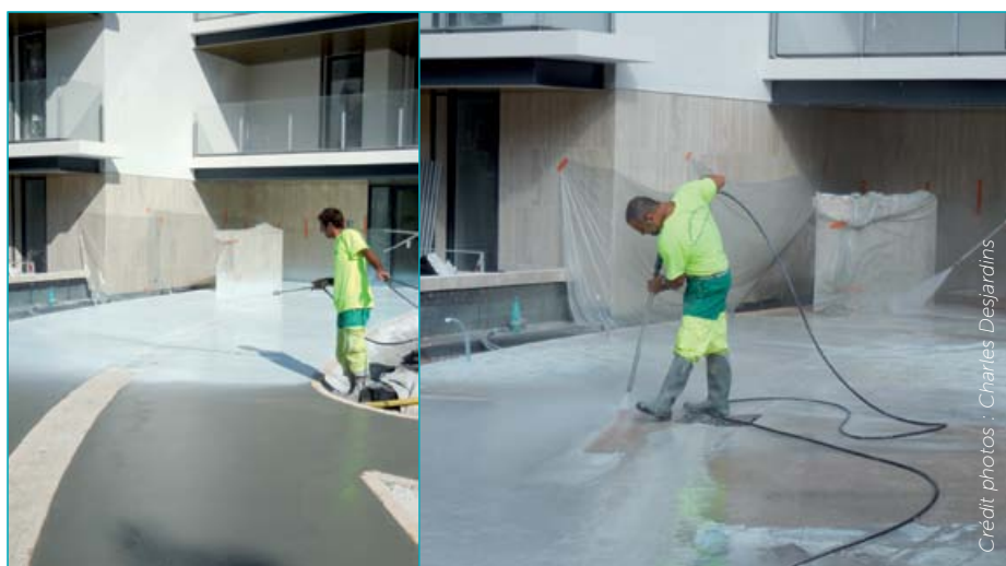
Phase 2 : pulvérisation d'un désactivant "bio", à raison d'un litre pour 4 à 5 m 2 . Après un délai d'environ 24 heures, la couche superficielle est dénudée à l'aide d'un nettoyeur haute pression.
