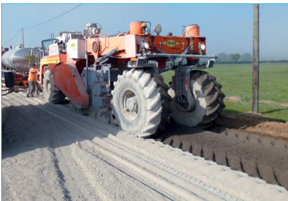
Etape importante : le malaxage. Au premier plan, le pulvimixeur malaxe et homogénéise le liant hydraulique avec les matériaux de l'ancienne chaussée.
