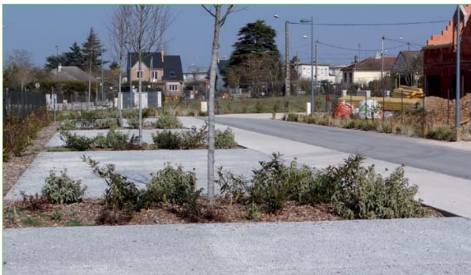
Dreux : les aires de stationnement du lotissement Marceau peuvent faire face à un épisode pluvial centennal, sans création d'un réseau d'assainissement et presque sans entretien.
