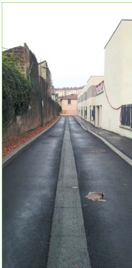
Villeurbanne : la nouvelle rue Jacques-Monod est longue de 170 m pour 3 m de largeur.
