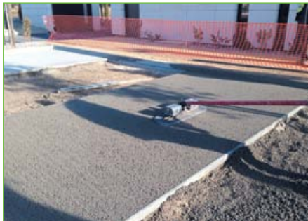
La Tour d'Aigues : pour une finition précise et esthétique du béton drainant, l'équipe de Provence Impressions a utilisé une lisseuse vibrante de type Mag Vibe.
