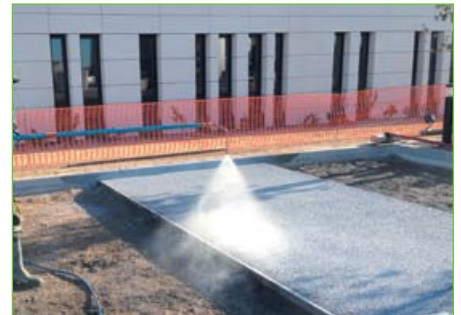
La Tour d'Aigues : en plus d'un nouvel additif introduit dans le béton, un produit permettant de révéler les granulats a été pulvérisé.
