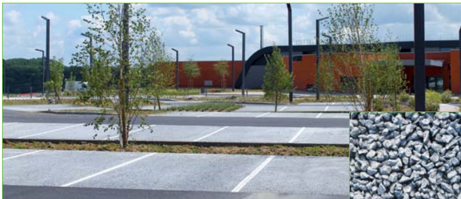
Pavilly-Barentin : 2 700 m 2 de parking en béton drainant ont été réalisés autour du centre aquatique de Pavilly-Barentin (Seine-Maritime).
