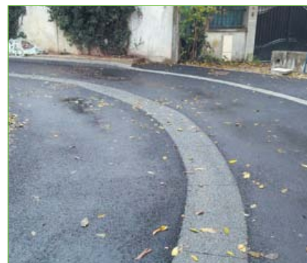
Villeurbanne : au centre de la voie, le caniveau drainant mesure 50 cm de largeur.
