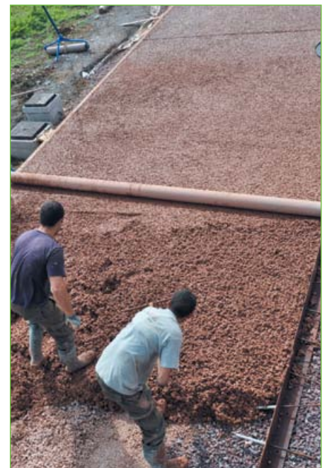
N.-D.-de-Lorette : le béton mis en œuvre au rouleau Striker sur le parvis contient des granulats rouges, du colorant ocre et un nouvel agent de cohésion mis au point par Grace.
