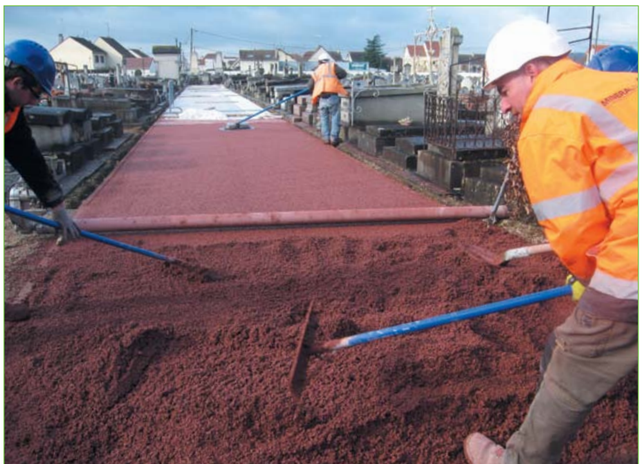
Les Mureaux : 85 m 2 de béton drainant ont été mis en œuvre dans le cimetière des Mureaux pour remplacer les gravillons.
