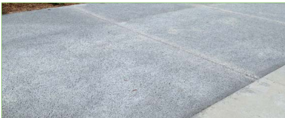
Dreux : le béton drainant absorbe quasi instantanément l'eau, la stocke (porosité 30 % environ) et la restitue lentement.
