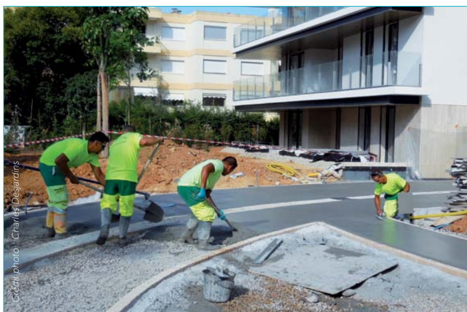
Phase 1 : acheminé par deux brouettes mécaniques à chenilles, le béton est d'abord étalé manuellement, égalisé à la règle aluminium et taloché, avant une finition à la grande lisseuse double arrondi.
