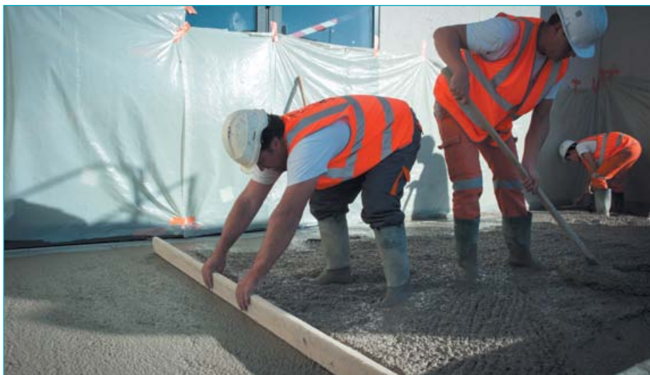
Les murs étant protégés, le coulage de la dalle commence par une répartition du béton au râteau suivie d'une égalisation à la règle en bois, préparant le talochage fin sur les bords.
