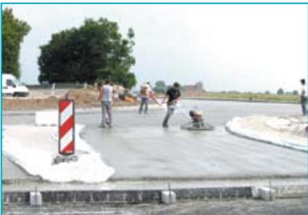
Nordhouse : avant son balayage superficiel, le béton est lissé au moyen d'un hélicoptère.
