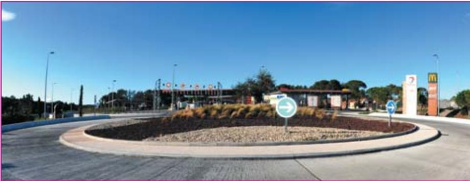
Les deux giratoires de l'A8 sont constitués de dalles en béton, coulées en place et goujonnées, qui dessinent deux anneaux concentriques de 4 m de large (ici celui de Canaver).
