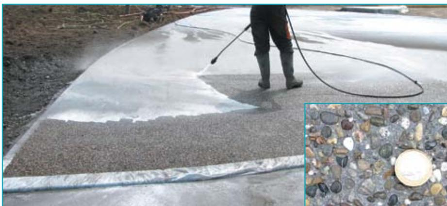
Nordhouse : le lendemain de l'application du désactivant de surface, le béton est lavé, laissant apparaître les granulats en surface.
