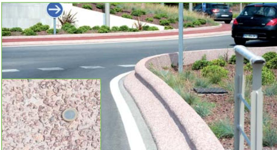
Port-Fréjus 2 : les glissières de sécurité en béton extrudé ont été désactivées pour laisser apparaître le granulat rose.
