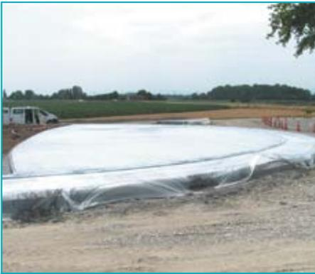
Nordhouse : un film polyane protège le béton désactivé de l'anneau central afin de permettre au chantier de se poursuivre.
