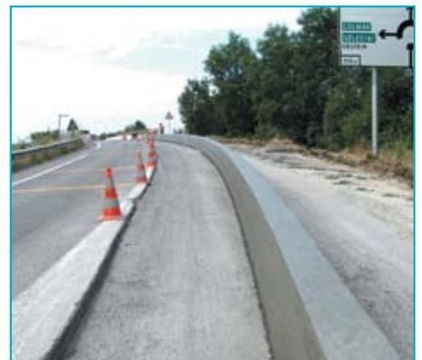
Nordhouse : 25 m<sup>3</sup> de béton extrudé ont été utilisés pour réaliser les glissières de sécurité des voies d'accès au giratoire.
