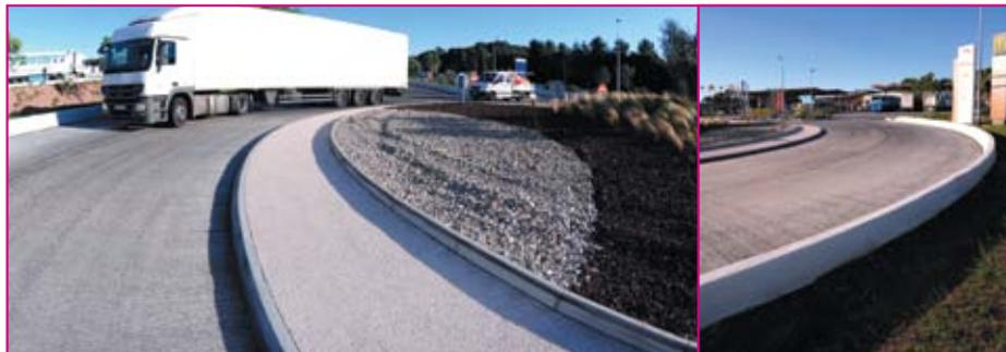
Les bordures intérieures et extérieures des deux giratoires, réalisées en béton extrudé, ont servi de coffrage et le béton désactivé des îlots centraux a été coloré dans la masse.
