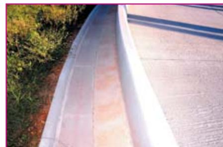
À l'arrière de la glissière, un béton drainant de 15 cm d'épaisseur sur 30 cm de large évacue les eaux pluviales vers des exutoires.
