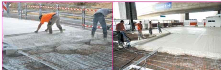
Le dressage du béton est réalisé à la règle pour les petites surfaces (à gauche) et au rouleau hydraulique pour les grandes surfaces (à droite).
