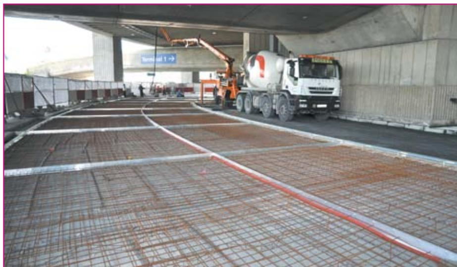
La double nappe de treillis métallique et les joints sont posés avant le coulage du béton, mis en œuvre à la pompe.
