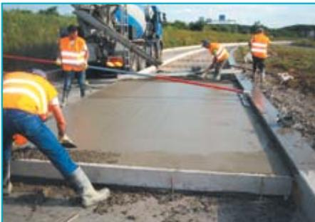
Pour des raisons d'accessibilité, la majeure partie (70%) du lot METTIS Sud 2 a dû être réalisée manuellement par demi-chaussée (3 mètres), voire quart de chaussée, avec alimentation par toupie.
