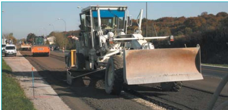
Le passage de la niveleuse permet d'obtenir une surface plane et de régler la couche à la hauteur définitive exigée.
