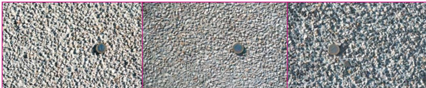
Les concepteurs du tramway ont créé des bétons désactivés dont l'aspect et la granulométrie des granulats ont été choisis en fonction des usages : un gris très clair et une granulométrie moyenne pour les îlots piétons (à gauche), un gris clair à faible granulométrie pour les trottoirs (au centre) et un gris moyen et une granulométrie fine pour la plateforme (à droite).
