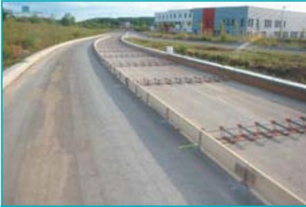
Coffrage longitudinal en attente de la mise en œuvre manuelle du béton.
