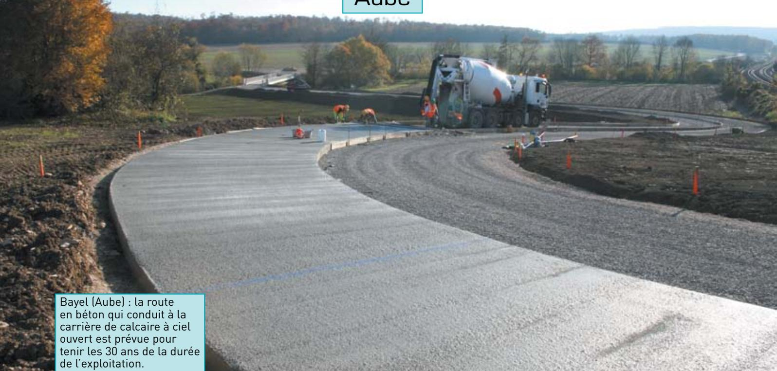
Bayel (Aube) : la route en béton qui conduit à la carrière de calcaire à ciel ouvert est prévue pour tenir les 30 ans de la durée de l'exploitation.
