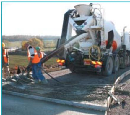
Initialement prévue sur 16 cm, l'épaisseur de la couche de roulement de béton BC5 a été portée à 20 cm afin de garantir une bonne tenue de la chaussée sur 30 ans.
