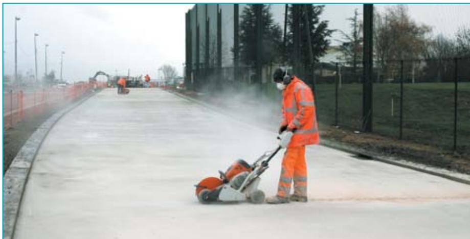
Moment important de la mise en œuvre du béton : le sciage de la dalle en béton, avec un joint de retrait transversal tous les 4 mètres.
