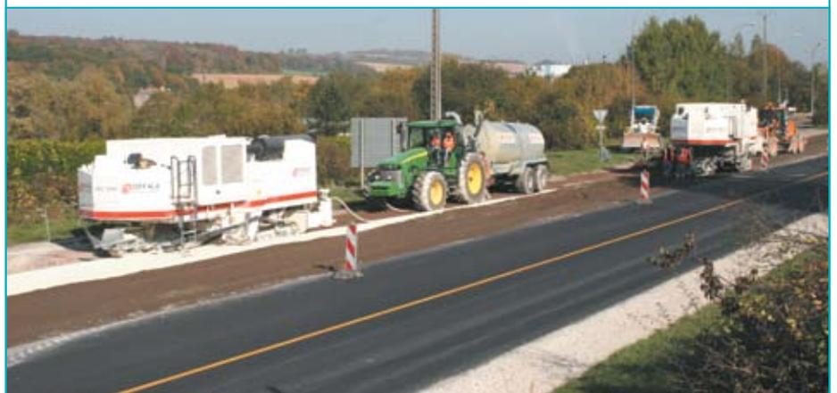
Sur ce chantier, deux ateliers de retraitement de chaussées travaillent en parallèle : à gauche, le nouvel ARC 1000 et à droite, l'ARC 700.
