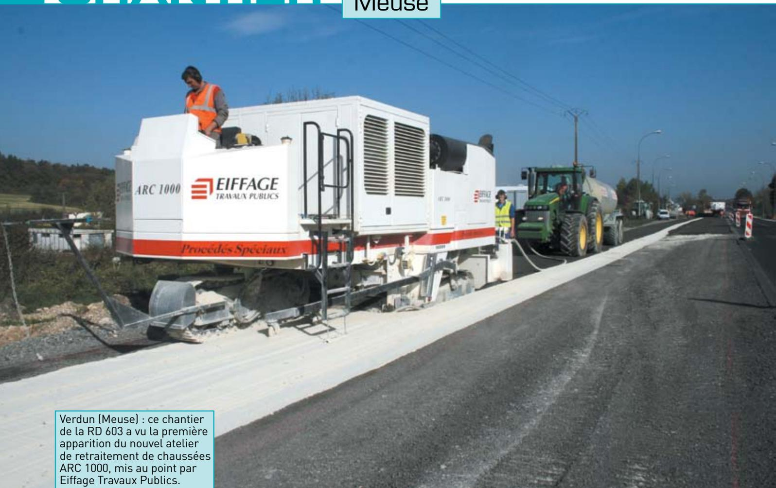
Verdun (Meuse) : ce chantier de la RD 603 a vu la première apparition du nouvel atelier de retraitement de chaussées ARC 1000, mis au point par Eiffage Travaux Publics.
