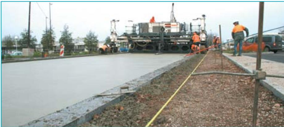
La machine à coffrage glissant travaille en pleine largeur (6,50 mètres) avec guidage au fil.
