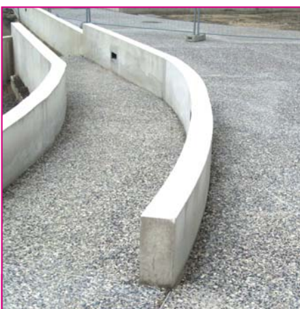
Quartier Marinot (Calais) : rampe d'accès pour les personnes à mobilité réduite. Le revêtement, en béton fibré désactivé, est moucheté grâce au mélange de deux granulats différents : un 4/12,5 gris et un 6/14 noir.
