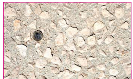
Les gros granulats concassés calcaires 11/22 limitent les glissades lorsque la dalle est mouillée par les paquets de mer.
