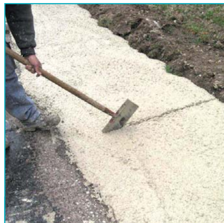
Tous les 10 mètres, une simple lame d'acier sert à préfissurer le MACES, sur 5 à 10 cm de profondeur, ce qui permet de canaliser la fissuration de retrait.
