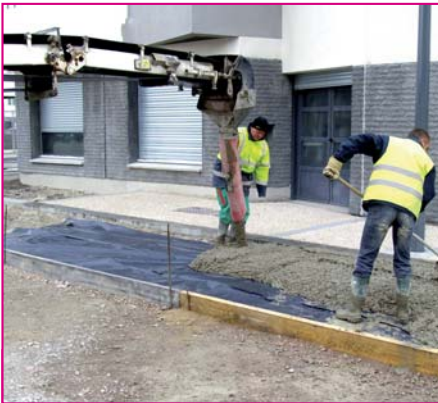
Quartier Matisse (Calais) : l'étroitesse de certains accès implique, pour acheminer le béton prêt à l'emploi, de recourir à un tapis transporteur.
