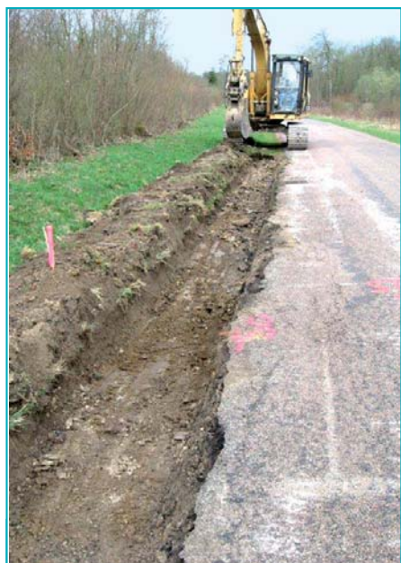
Une simple pelle mécanique suffit pour creuser la fouille et en lisser le fond.
