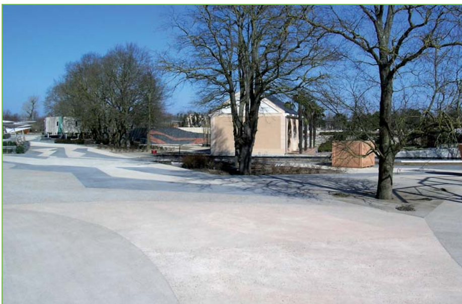
Coulé par bandes successives, le béton sableux coloré micro-désactivé est décliné en six teintes différentes rappelant les couleurs de l'Anjou.
