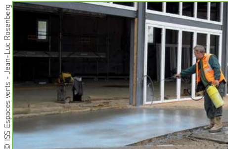
La pulvérisation du désactivant en phase aqueuse demande un savoir-faire précis.
