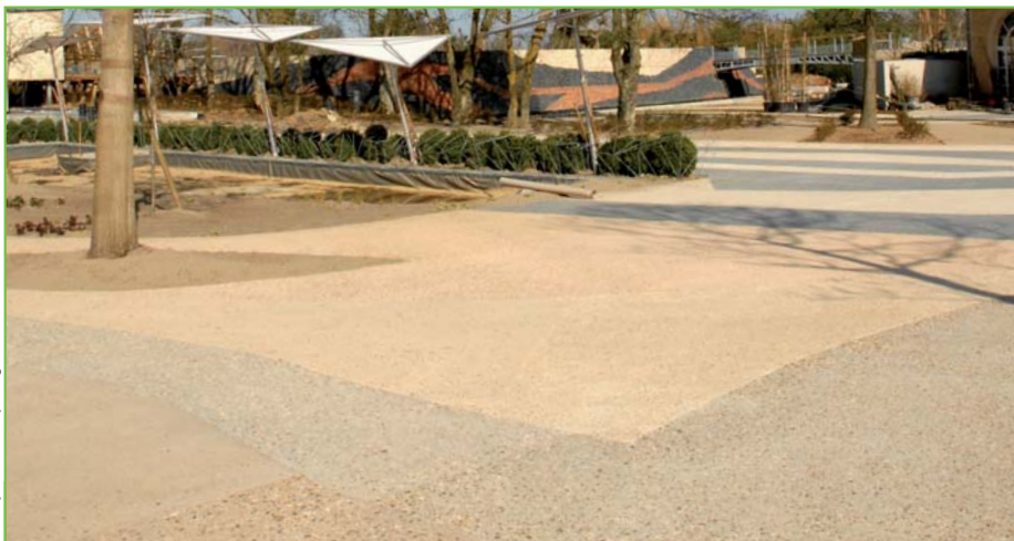
Le processus de désactivation, spécifique à ce chantier, donne aux bétons sableux colorés micro-désactivés l'aspect patiné qui était recherché.
