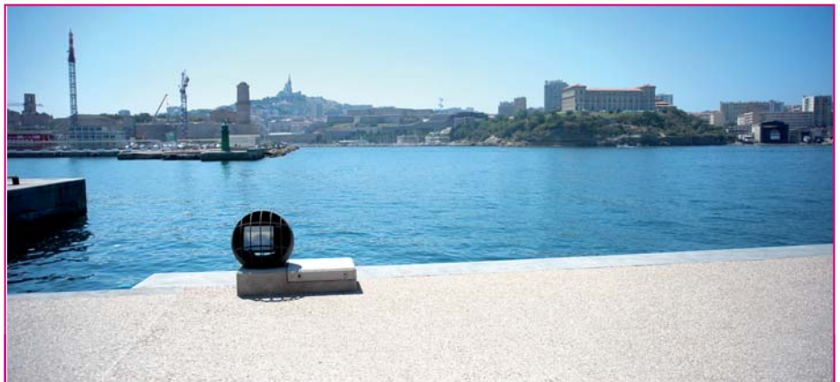
La dalle de la digue Sainte-Marie, réalisée en béton désactivé de 14 cm d'épaisseur sur une surface de 4 070 m 2 , fait face à Notre-Dame de la Garde.
