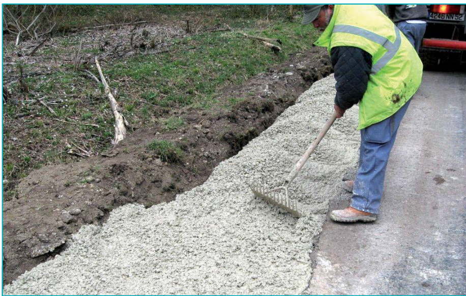
Après déversement, le MACES est uniformément réparti au râteau.
