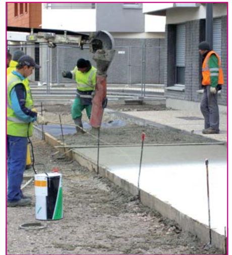
Quartier Matisse (Calais) : une pulvérisation homogène d'un produit désactivant, à la surface du béton, est indispensable.
