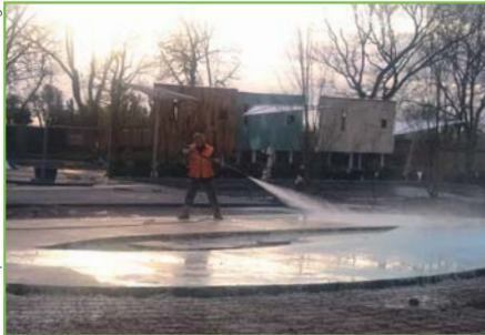
La phase de lavage permet d'éliminer le désactivant et la laitance.
