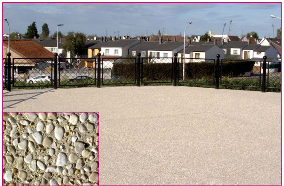
Quartier Matisse (Calais) : la terrasse surplombant le blockhaus présente un béton désactivé à base de gros granulats beige clair.
