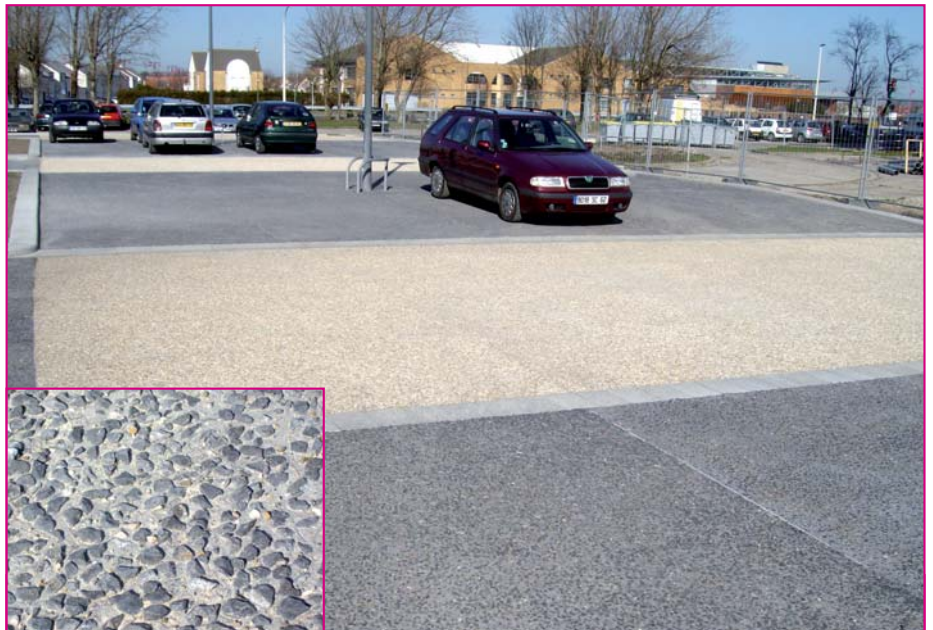
Quartier Marinot (Calais) : des granulats noirs 10/14 roulés de basalte (Corrèze) donnent sa teinte au béton désactivé des places de stationnement, contrastant avec la voie de circulation claire des véhicules.
