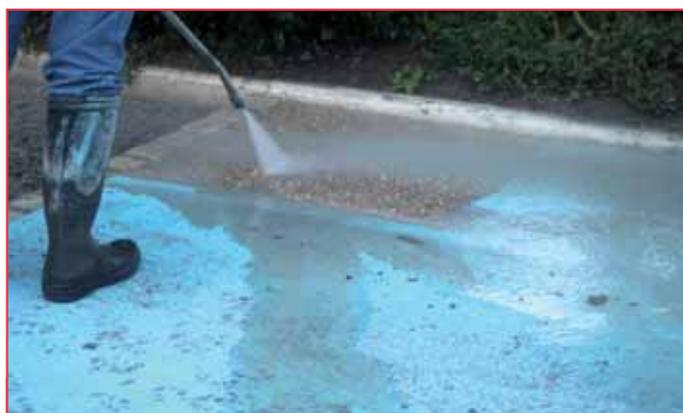
Le lavage du béton désactivé, au jet d'eau haute pression, élimine le désactivant et la laitance, pour faire apparaître les granulats.
