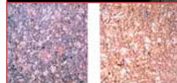
Têtes de bouchardage, avec gros plans de béton bouchardé.
