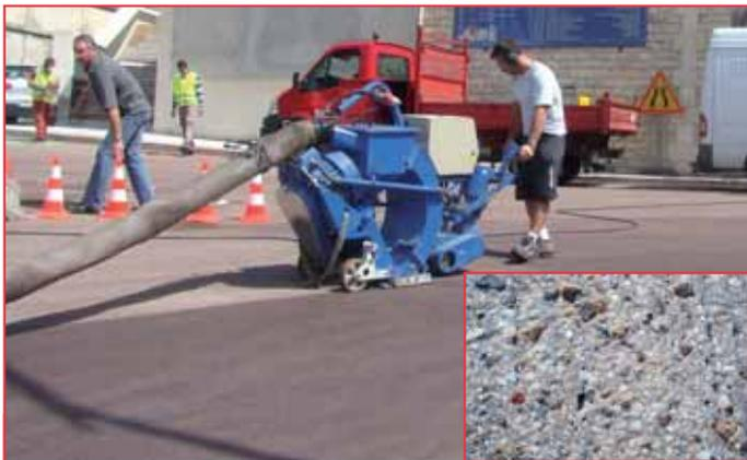
Machine de grenailage (ou grenailleuse) en action, avec gros plan de béton grenailé.
