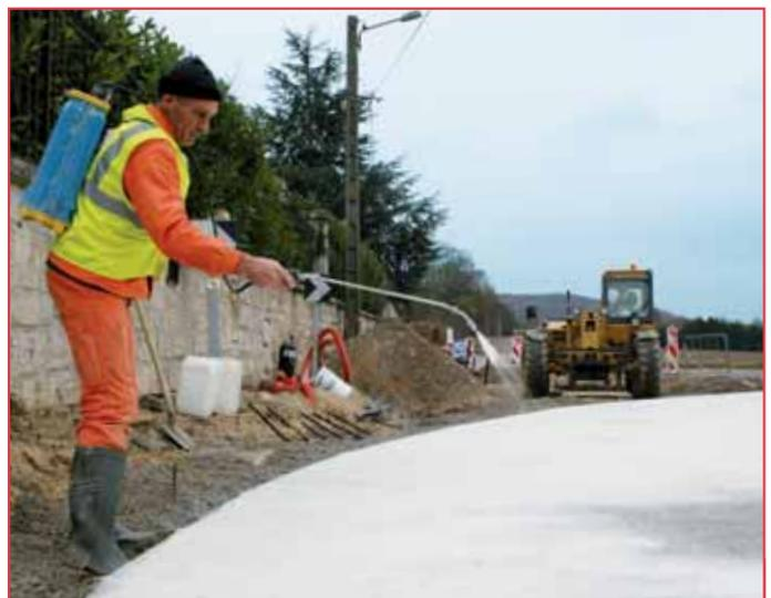
Giratoire de Crouy (Aisne) : une fois le béton coulé, on pulvérise un bio-désactivant puis un produit de cure.
