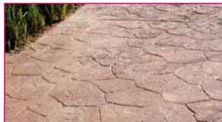
Les allées et les zones de détente sont réalisées en béton imprimé de façon irrégulière, technique dite "opus incertum".
