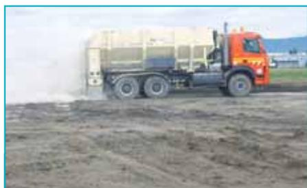
L'épandage du liant hydraulique routier est réalisé à raison de 35 kg/m<sup>2</sup>.
