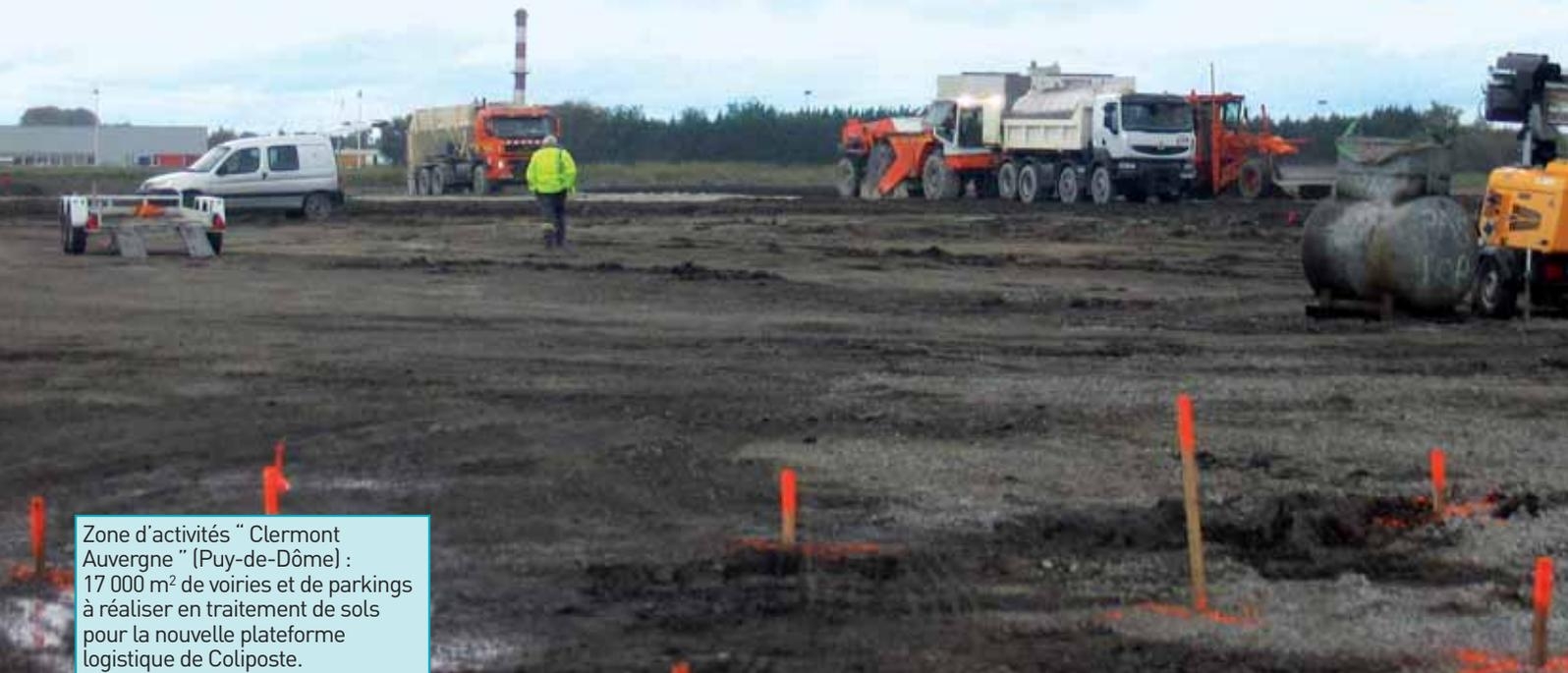
Zone d'activités " Clermont Auvergne " (Puy-de-Dôme) : 17 000 m<sup>2</sup> de voiries et de parkings à réaliser en traitement de sols pour la nouvelle plateforme logistique de Coliposte.
