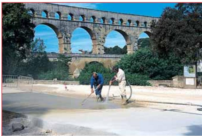
Pont du Gard. Exécution du sablage au jet de sable à haute pression.
