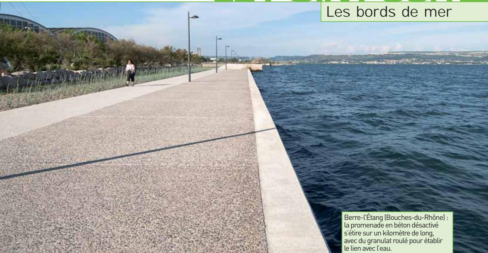
Berre-l'Étang (Bouches-du-Rhône) : la promenade en béton désactivé s'étire sur un kilomètre de long, avec du granulat roulé pour établir le lien avec l'eau.
