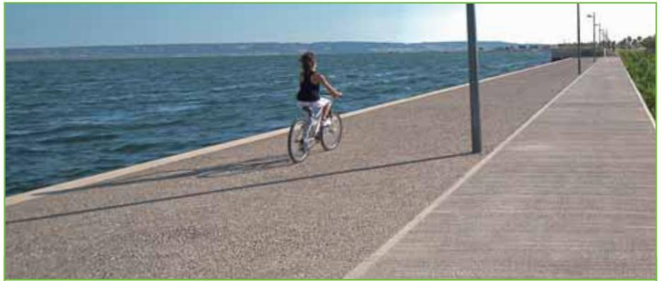
Berre-l'Étang : à gauche, du béton désactivé avec des granulats roulés sur le quai-promenade piétons. À droite, du béton balayé pour le parcours cyclable dans le parc.
