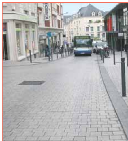
Première expérience à Angers (2003) : la rue Plantagenet, une voie en pente supportant un trafic de 400 bus/jour.
