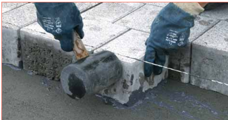
Ajustement précis de l'alignement et du calage des pavés.
