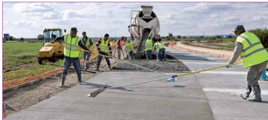
Lissage du béton de fraisats.
