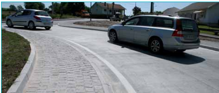
Une bande pavée borde la chaussée en béton à l'intérieur du giratoire, créant ainsi un contraste visuel qui incite les conducteurs à être plus vigilants.
