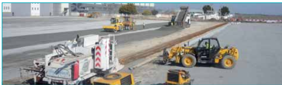
Mise en place de la grave liant et des armatures métalliques pour le caniveau à fente.
