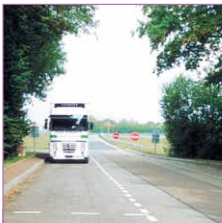
Aire de repos pour poids lourds des Châtagniers (Loiret), sur l'autoroute A6 au nord d'Auxerre : à gauche, voie en béton de ciment mince collé (BCMC) et, à droite, voie bicolore en béton de fraisats d'enrobés.
