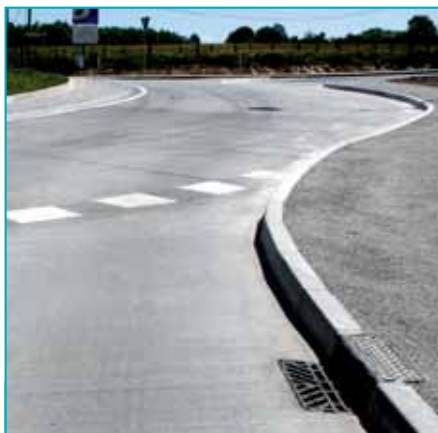
Les bordures préfabriquées en granit ont servi de coffrage lors du coulage.
