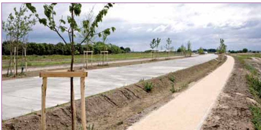
L'axe principal de la zone d'activité, côté sud. De gauche à droite : voirie en béton, noue (écoulement des eaux) et trottoir en stabilisé.
