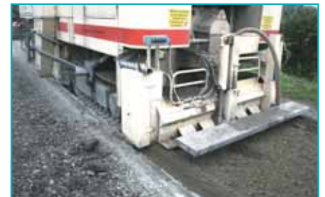
Malaxage en place de l'assise de l'ancienne chaussée, au moyen de liant hydraulique routier.
