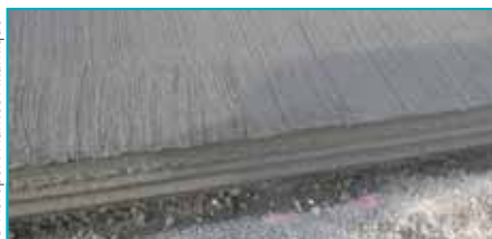
Profil sinusoïdal du béton pour emboîtement de deux dalles adjacentes.
