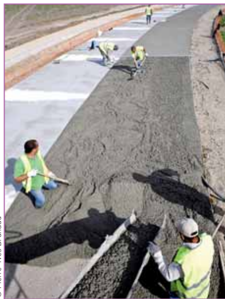
Mise en œuvre du béton de fraisats.
