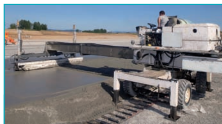
La machine à table vibrante assure réglage et vibration du béton.
