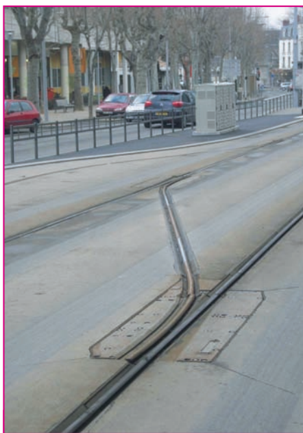
Pour les 16 appareils de voie (zones de croisement, aiguillages, parties intermédiaires...), le béton a été préféré à l'enrobé.
