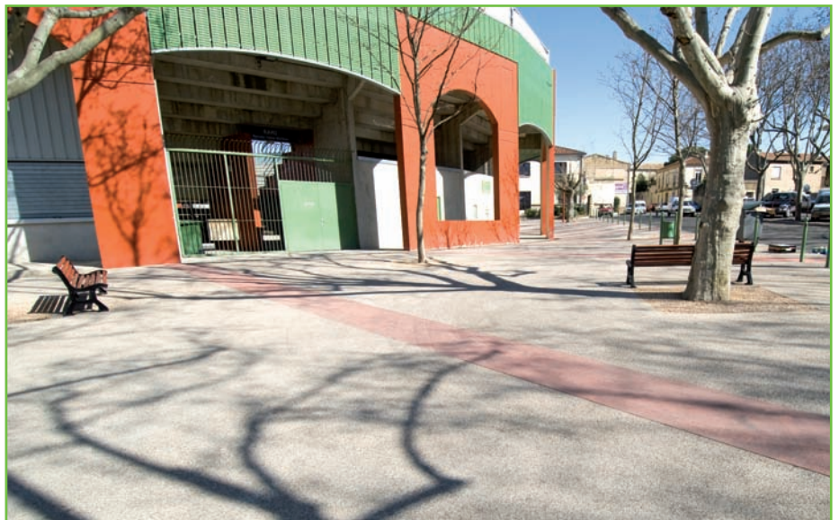
Vauvert : le calepinage de la place a été réalisé avec des bandes structurantes de béton coloré rouge dans la masse.
