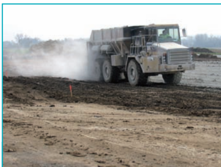
Après le premier arrosage, l'épandage du liant hydraulique routier intervient à raison de 32 kg/m 2 .
