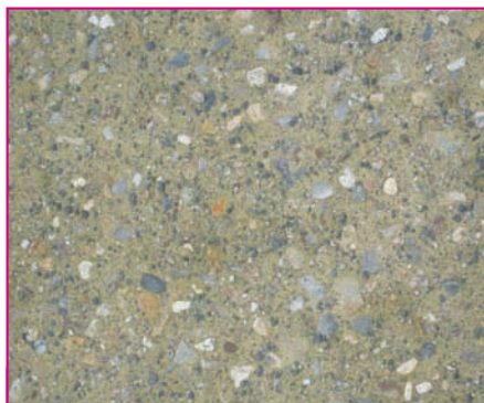
Lors du grenailage, la laitance est enlevée, ce qui fait apparaître les granulats et les détails du béton sur quelques millimètres.
