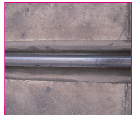
Après la réalisation de l'engravure, le rail a été posé et scellé avec de la résine.
