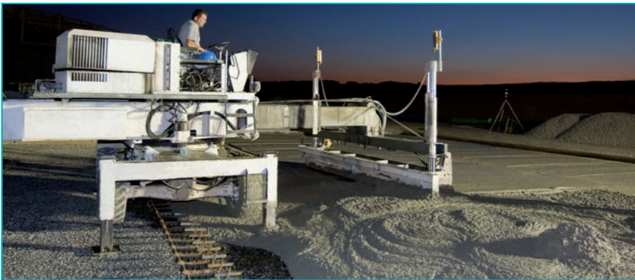
Le bétonnage a permis de réaliser environ 1 100 m 2 de chaussée par nuit. Au premier plan, goujons et chambres de glissement délimitent des carrés de 6,50 m de côté.
