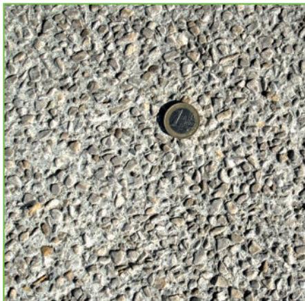
Vauvert : la finesse du granulat offre tout le confort requis pour les déplacements piétons.
