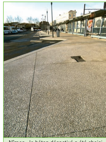
Nîmes : le béton désactivé a été choisi pour les trottoirs du parvis sud de la gare routière.
