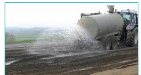
Un bon arrosage, avant et après le passage du rotomulaxeur, assure la bonne hydratation du liant hydraulique routier.
