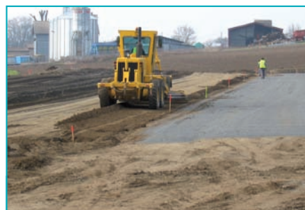
Le nivelage précède le passage du compacteur à roues.
