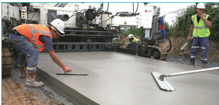
La machine à coffrage glissant met en forme le béton, le règle et le vibre de façon régulière d'un bout à l'autre du chantier, sur une épaisseur de 20 cm.
