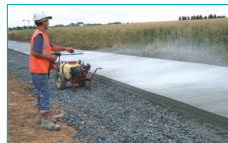
La pulvérisation d'un produit de cure protège la prise du béton.
