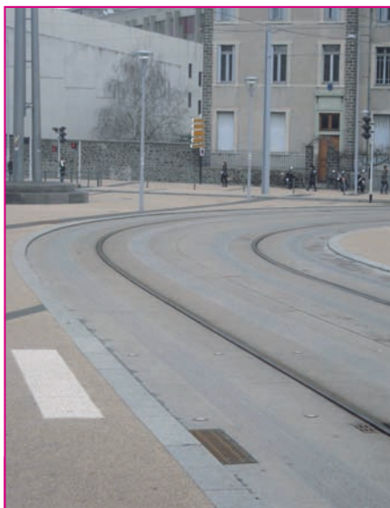
Le court rayon de giration du Translohr (10,5 m seulement) lui permet de s'insérer parfaitement dans le tissu urbain clermontois.
