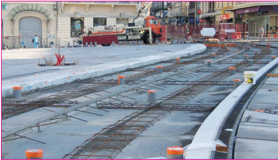
Un ferrailage longitudinal a été réalisé à l'aplomb de l'engravure du rail et des paniers de goujons transversaux.
