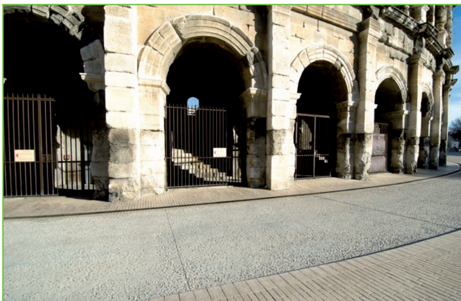
Nîmes : autour des arènes, les circulations piétonnières ont été aménagées avec une granulométrie moindre pour augmenter le confort des piétons.
