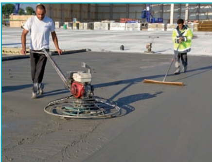
Le béton est lissé avec un hélicoptère, puis balayé manuellement.
