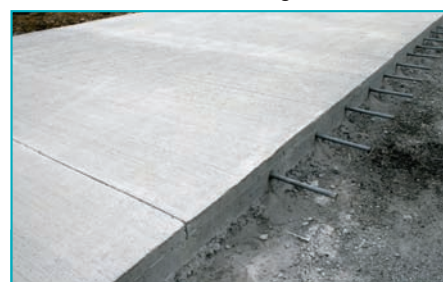
Des aciers sont prévus au niveau du raccordement des aires de dépassement.
