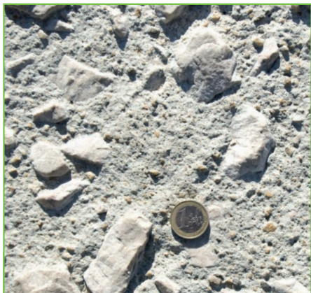
Nîmes : des granulats hors-norme 60-80 ont été mis en œuvre pour la réalisation du béton du parvis des arènes.
