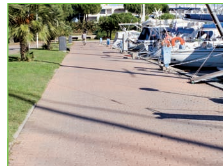
Port-Camargue : les pavés en béton font aussi partie de la panoplie des matériaux utilisés pour les quais du port.
