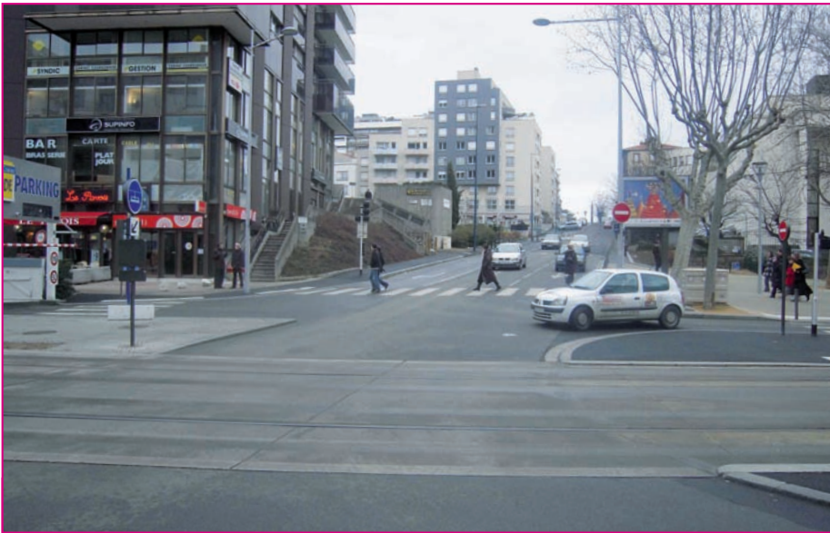
Aux carrefours, la délimitation du gabarit limite d'obstacles été réalisée en bande de résines avec un saupoudrage de granulats naturels 2,5/5 de coloris gris flanelle.
