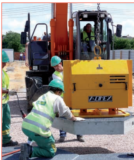
Le levage des dalles s'effectue à l'aide d'un engin de chantier courant, muni d'un système de ventouse.
