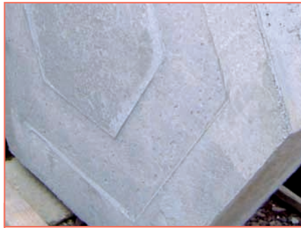
Sur la face inférieure des dalles, a été créé un rebord de 1 cm d'épaisseur sur 15 cm de large, permettant d'éviter tout battement sous trafic.
