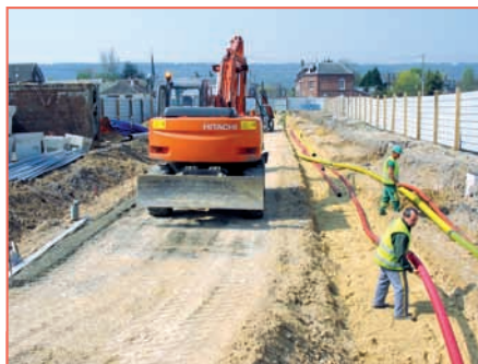
La mise en place des réseaux intervient en premier lieu.
