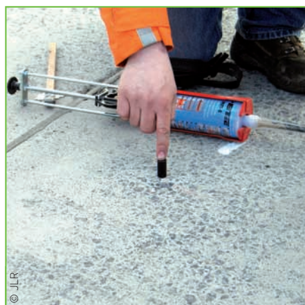
Tous les 2 mètres sont implantés dans le béton des plots magnétiques émettant des signaux lus par le tram.
