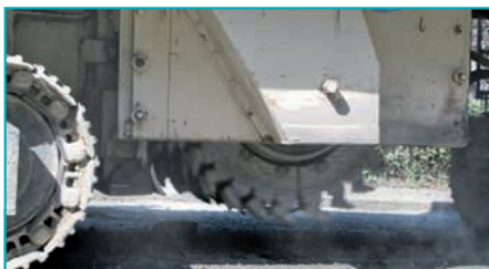
LARC 700 défonce l'ancienne chaussée sur 30 cm d'épaisseur.
