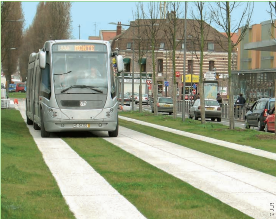
Boulevard de la République : la plate-forme du tram associe couche de roulement en béton armé et parties engazonnées.
