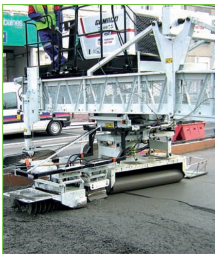
La Gomaco C450 a permis de couler le béton en continu, sur des largeurs pouvant varier de 2,80 à 8,50 mètres.
