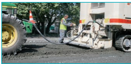
Matériaux extraits et liant sont mélangés, pendant que l'arrosage régulier est asservi à l'avancement des machines.
