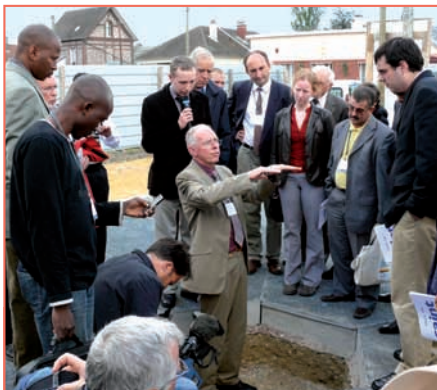
Jean-Marie Masson démontre la grande facilité d'intervention sur un réseau de chaussée urbaine démontable.
