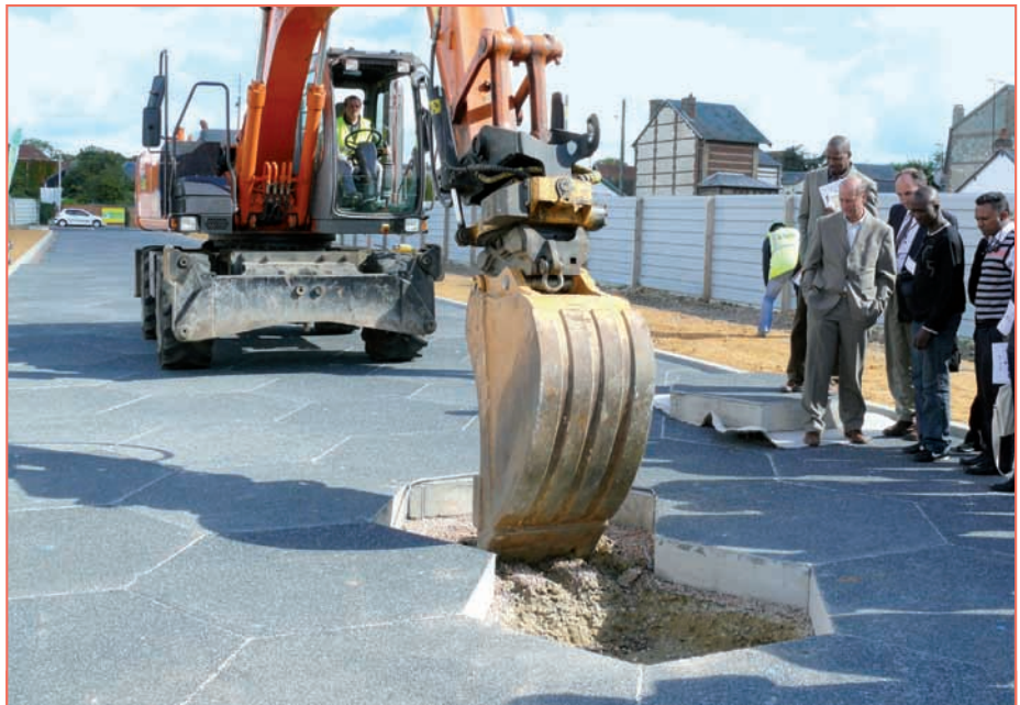
Pour intervenir sur un réseau de chaussée urbaine démontable, il suffit de soulever quelques dalles, puis de creuser.
