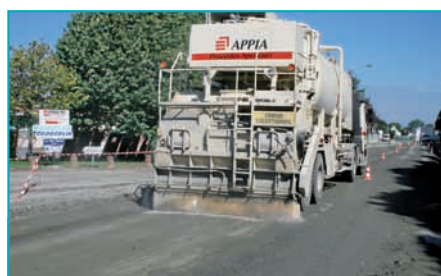
La machine d'épandage applique la quantité adéquate de liant au m 2 .
