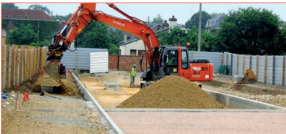
Au premier plan, à droite, le lit de pose de 3 cm d'épaisseur en granulats roses 6/10.
