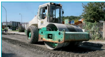
Le compactage final permet une remise en circulation immédiate.
