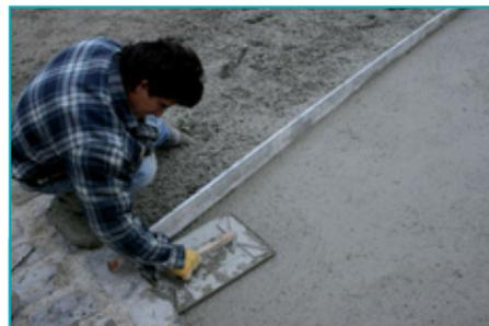
Une fois réglé à 23 cm d'épaisseur, le béton est soigneusement taloché.
