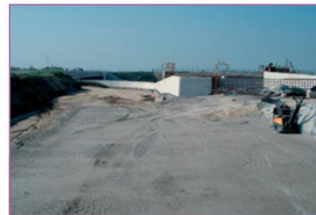
Roissy : la grave de béton concassé utilisée en remblais d'ouvrage d'art.
