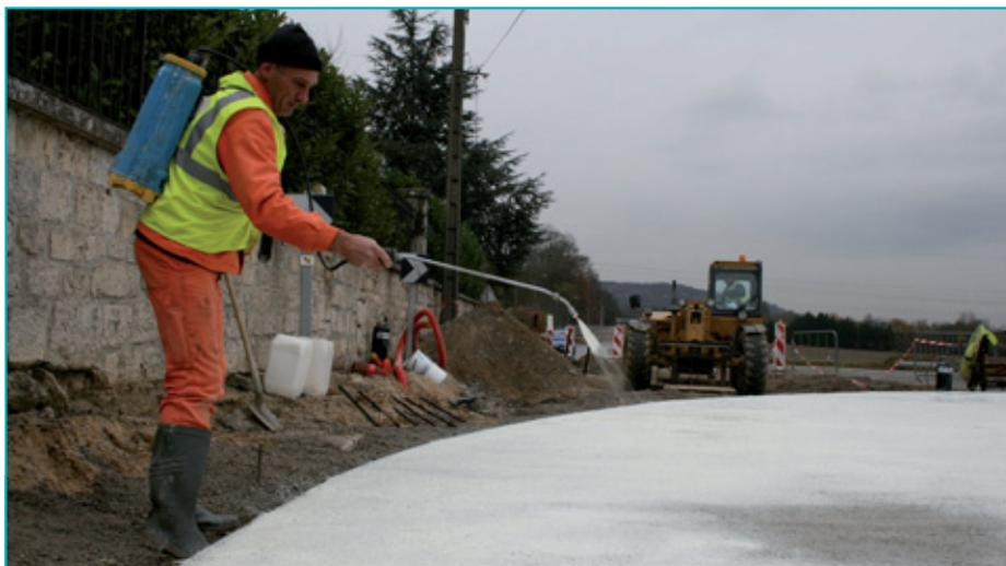
La protection du béton est assurée par la pulvérisation d'un produit de cure.
