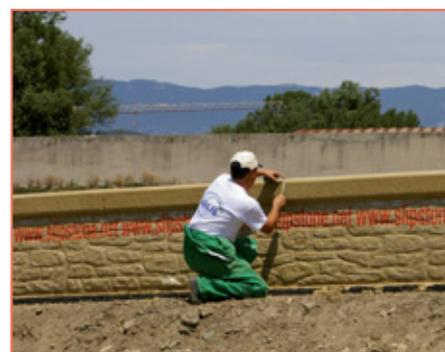
Contrôle de la partie supérieure lisse de la couvertine.
