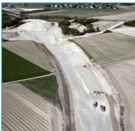
Le dernier tronçon de la rocade a nécessité le terrassement de 900 000 m<sup>3</sup>.
