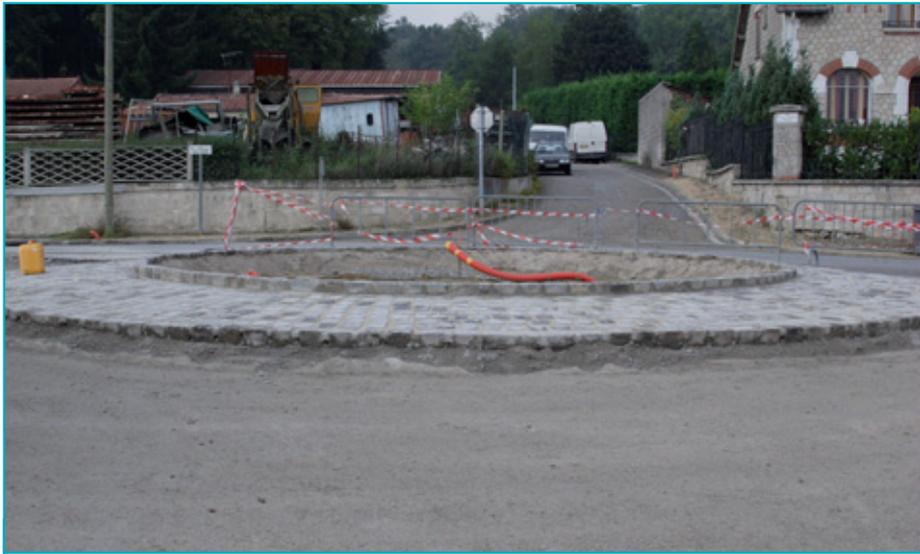
Structure du giratoire : au premier plan, couche de forme en grave traitée et compactée, puis anneau en pavés de grès et, au centre, partie engazonnée non circulaire.
