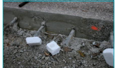
En haut : avant le coulage du béton, les goujons métalliques sont placés à la hauteur voulue, à l'aide de paniers. En bas : après décoffrage du béton, on voit le bon positionnement des goujons.
