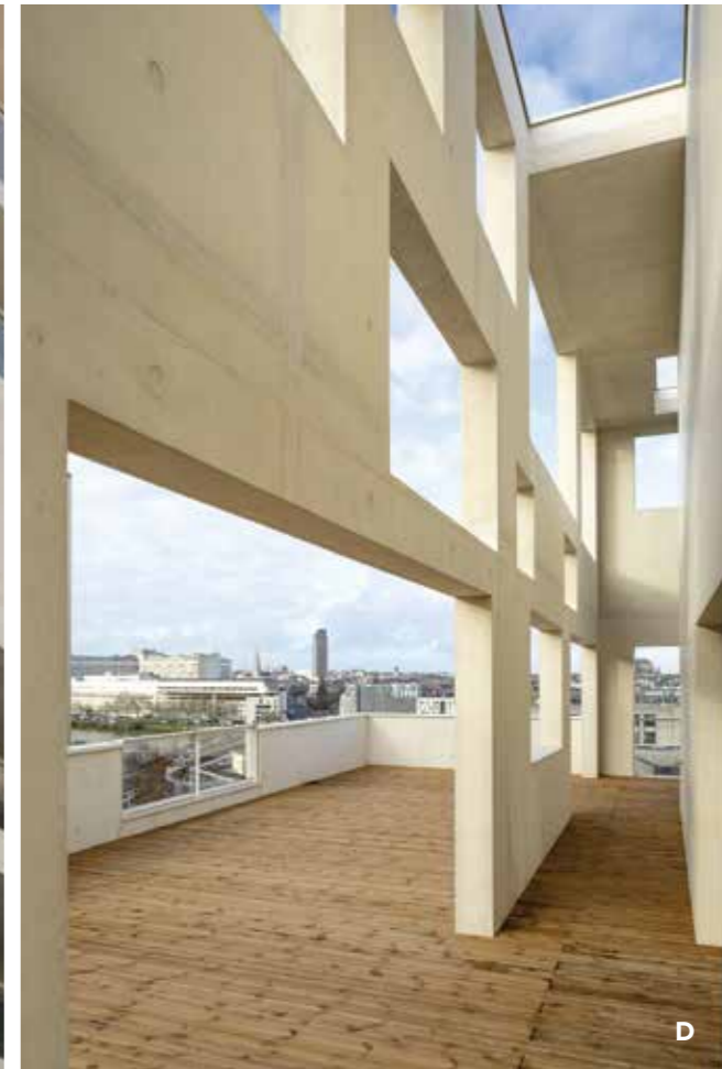
C ___ Le parement des bétons se rapproche de l'aspect de la pierre de tuffeau, emblématique de la ville de Nantes.
