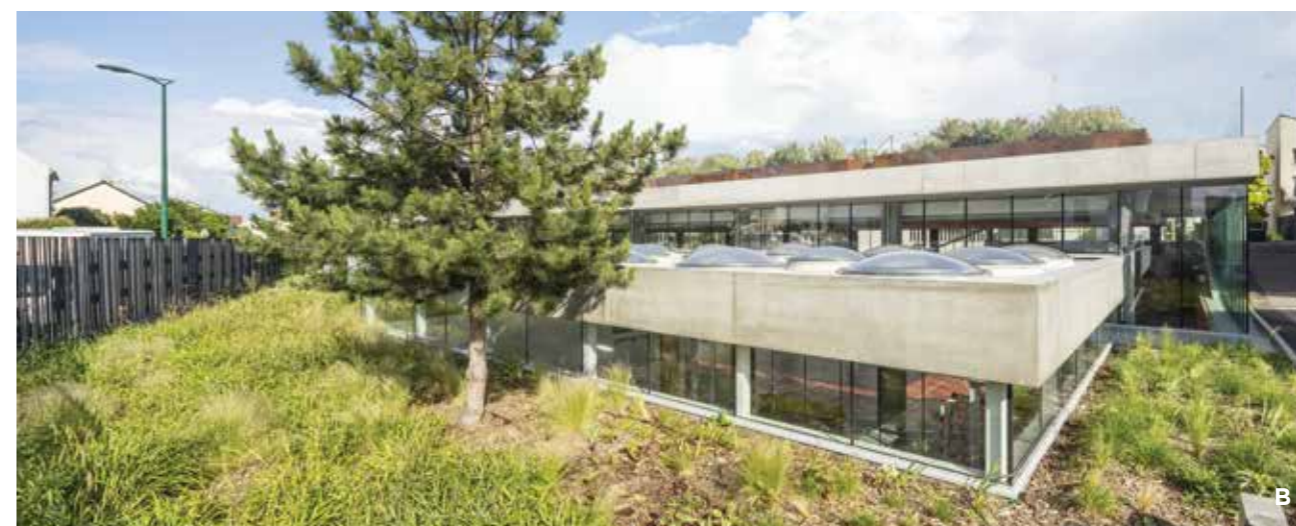
A La dalle de toiture en béton du gymnase, soulevée au-dessus du sol, accueille un jardin.
