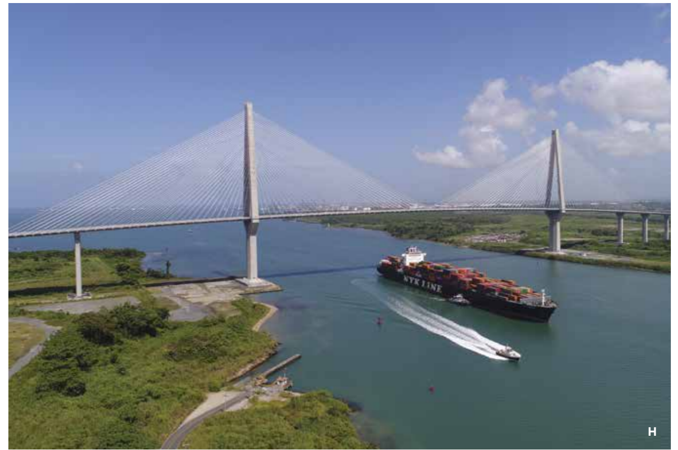
G Les voussoirs du pont à haubans sont construits de manière symétrique par rapport à chacun des pylônes, afin d'éviter le déséquilibre des charges.
