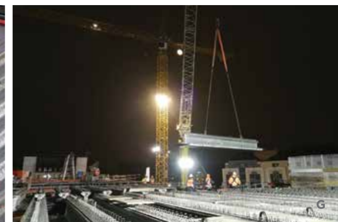
F, G Le tablier est constitué de poutres préfabriquées en béton en forme de T inversé.
