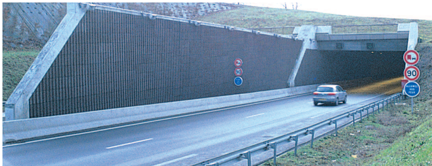
Tranchée couverte équipée de panneaux acoustiques.
