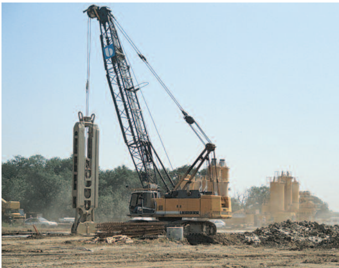
Réalisation d'une paroi moulée.
