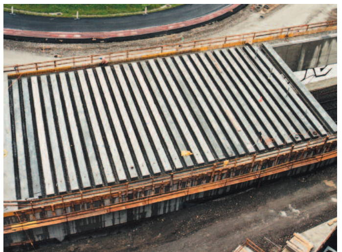
Couverture d'une tranchée couverte en poutres précontraintes.
