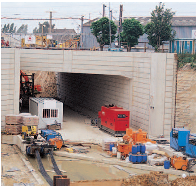
Ouvrage cadre mis en œuvre par "autoripage".
