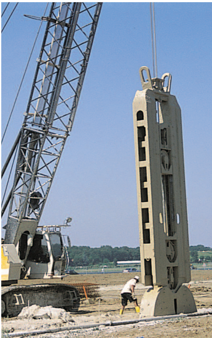
Réalisation d'un écran étanche.
