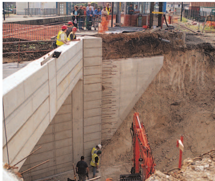
Ouvrage cadre mis en œuvre par "autoripage".
