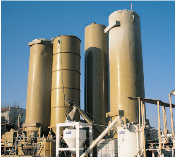
Centrale de fabrication du coulis bentonite-ciment.
