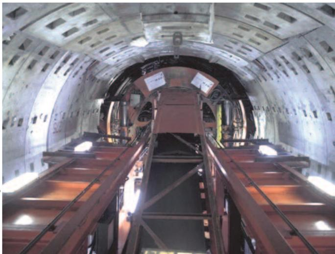
Voussoir préfabriqué en béton, en cours de pose (vue du tunnelier).
