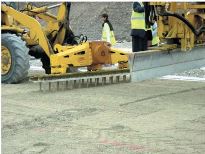
Système Joint Actif : réalisation d'une saignée sur toute la hauteur de la couche traitée.
