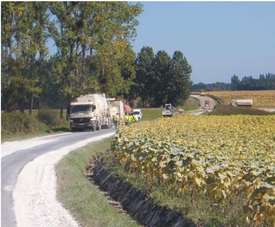
Vue générale d'un chantier de retraitement des chaussées en place à froid aux liants hydrauliques.
