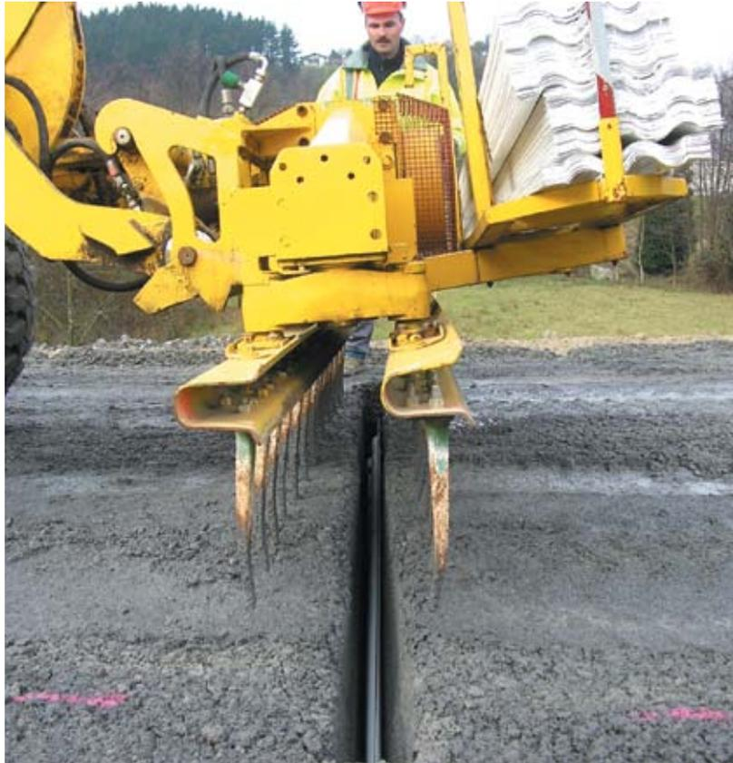
Systeme Joint Actif : introduction du joint à profil ondulé.
