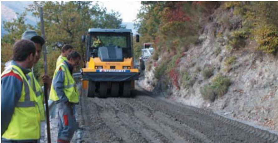
Le compacteur à pneus assure la bonne fermeture du matériau en surface et garantit ainsi une bonne finition.
