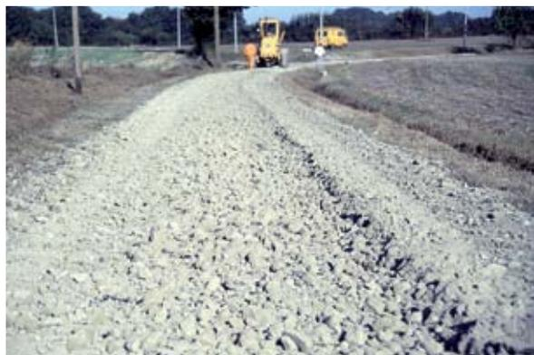
Matériel d'origine agricole à efficacité limitée : faible puissance, mouture grossière, mélange hétérogène.
