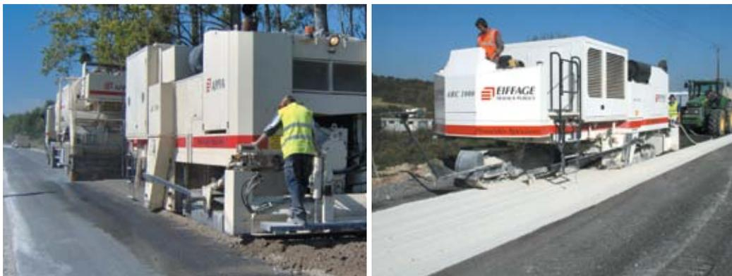
Ateliers de reconditionnement de chaussée : l'ARC 700 à gauche et l'ARC 1000 à droite.
