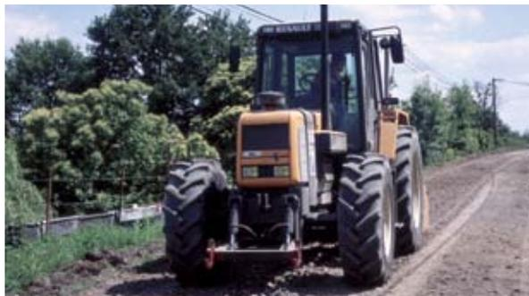
Le retraitement d'une chaussée en pavés nécessite au préalable une opération de concassage.
