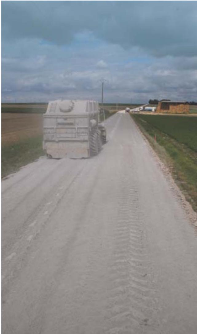
Épandage mécanisé au moyen d'un épandeur.
