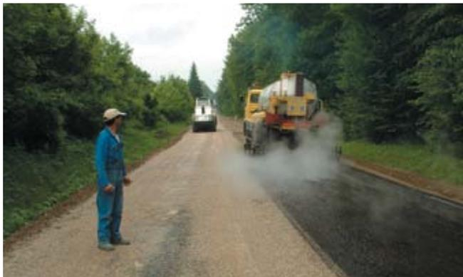
Protection contre la dessiccation par application d'une émulsion de bitume et sablage.
