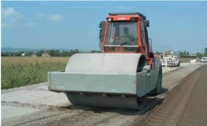
Le compacteur à cylindre lisse assure la densification du matériau à la partie supérieure de la couche.
