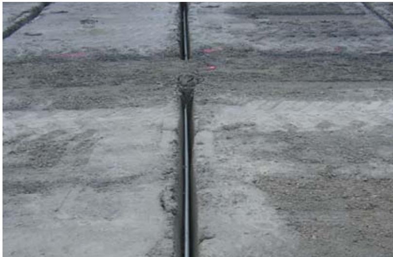
Systeme Joint Actif : joints installés dans les saignées, prêtes à être refermées.
