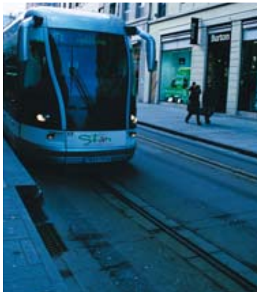
Tramway de Nancy. Traces d'ornières visibles dans les bandes de roulement.
