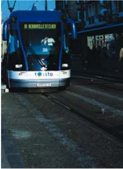
Tramway de Caen, surface bitumineuse ornierée.
