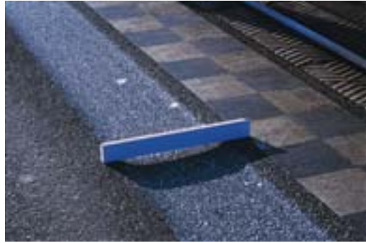
Tramway de Caen, surface bitumineuse ornierée.
