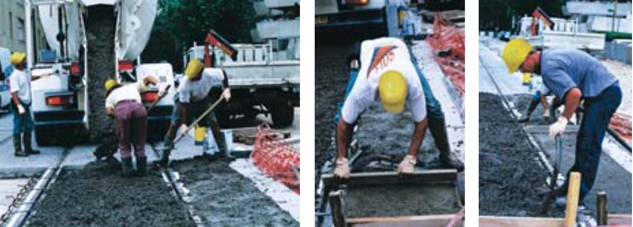
Mise en œuvre du béton.
