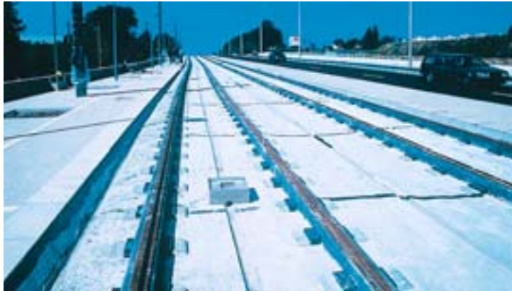
Tramway de Montpellier réalisé en béton compacté.
