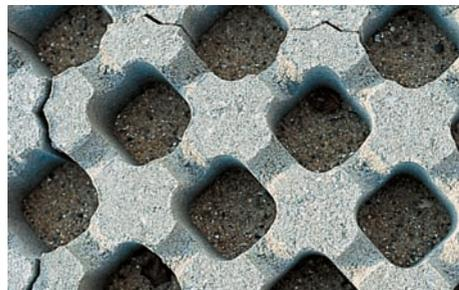
– les pavés et les dalles en béton perméables à l'eau, spécialement conçus pour assurer l'infiltration directe des eaux pluviales, apportent une réponse aux « techniques d'assainissement alternatives » et en particulier à la technique des chaussées réservoirs. En effet, la voirie représente une grande partie des surfaces
