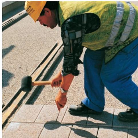
butées d'alignement lors de la pose. La pose à joints larges ne peut s'envisager sans étude particulière. En aucun cas, l'épaisseur du joint large ne peut excéder 10 % de l'épaisseur du produit. D'une façon générale et particulièrement pour les ouvrages de dimensions importantes, il est nécessaire de vérifier la rectitude et le parallélisme des rangs de pavés au moins tous les 4 à 5 m.
