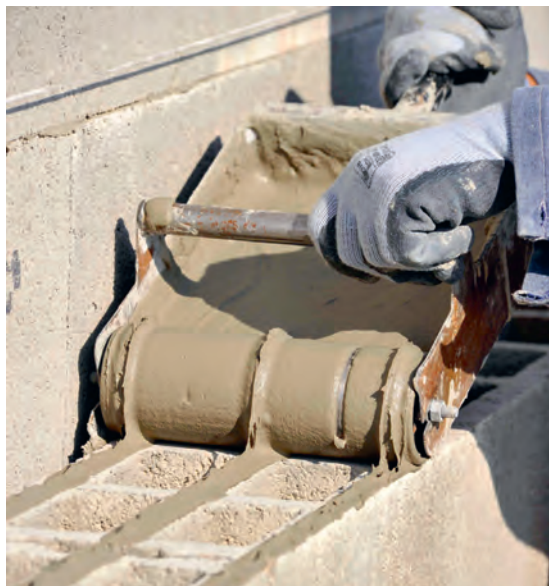
Figure 21. Mise en œuvre de la colle (© FIB).
