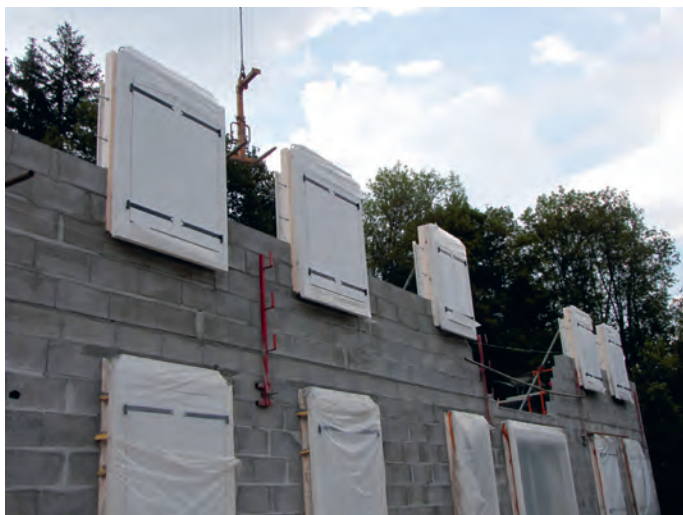
Figure 27. Mise en œuvre d'encadrements monoblocs (© FIB).
