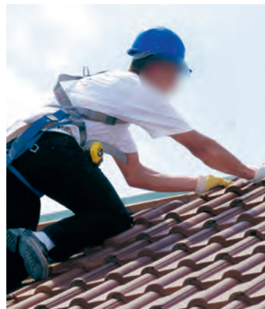
Figure 48. Toiture en cours de réalisation en sécurité (© FIB).
