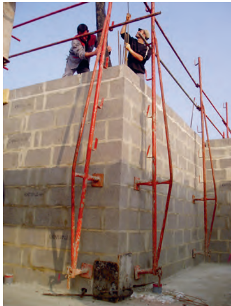
Figure 25. Mise en œuvre des blocs béton en sécurité (© FIB).
