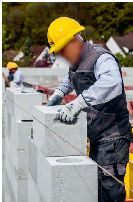
Figure 26. Pose de blocs en béton cellulaire (© FIB).
