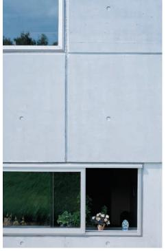
L'usage de béton autoplaçant (BAP) et de coffrages métalliques a été déterminant dans la réalisation de ces façades. La mise en œuvre du BAP a autorisé des coulages en une fois des deux étages, et l'absence de reprise apparente garantissait l'homogénéité du parement. La longueur des linteaux de certaines fenêtres pouvant aller jusqu'à 7 m, la
