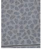
est homogène et brillante, la trame régulière des vitrages au nu extérieur accroche la lumière de manière uniforme. Mais de près, les panneaux en béton de marbre et de ciment gris clair sont tachetés par des inclusions de béton gris sombre accentuant la lecture de la composition de la matière. Dans les premiers projets, le contraste était encore renforcé par des inserts de marbre noir dans du ciment blanc.
