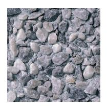
enlevée par lavage au jet d'eau, à la brosse ou par sablage à faible pression suivant la profondeur du traitement. Cette technique est à la fois souple car elle permet le traitement de panneaux de grande dimension et précise car la profondeur de l'attaque est parfaitement maîtrisée. Stanislas Fiszer utilise cette technique au siège des chaussures André à
