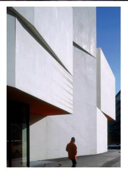
matériaux, la brique étant plutôt réservée au logement, les bâtiments appartenant à la collectivité utilisant quand à eux des matériaux plus exceptionnels. Le béton mis en œuvre ici est un béton brut de ciment blanc à l'oxyde de titane (béton autonettoyant) coulé en place. La matière et la luminosité de ce béton mettent en valeur le jeu des masses et des volumes sculptés par l'architecte pour structurer l'espace urbain et renforcent le caractère exceptionnel de cet équipement.
